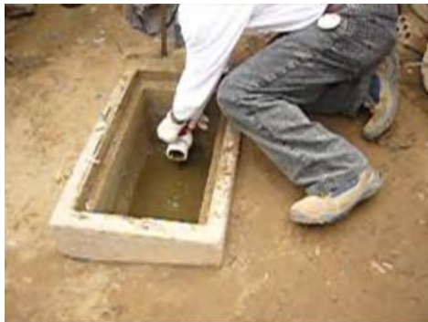
Figura 2.29.- Cierre de válvula.
