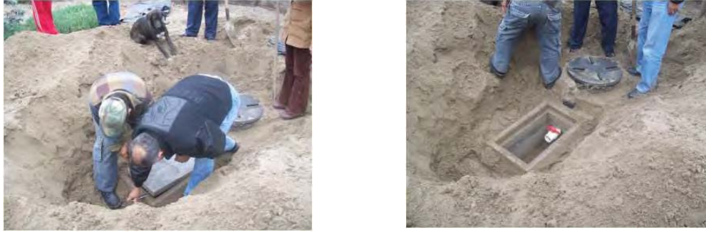
Figura 2.25.- Retiro de tapa de registro
