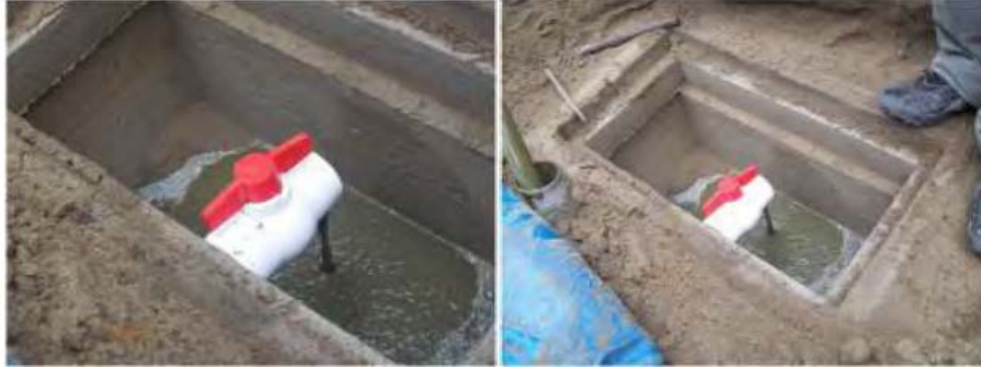
Figura 2.28.- Fluído de lodos hacia el registro.
