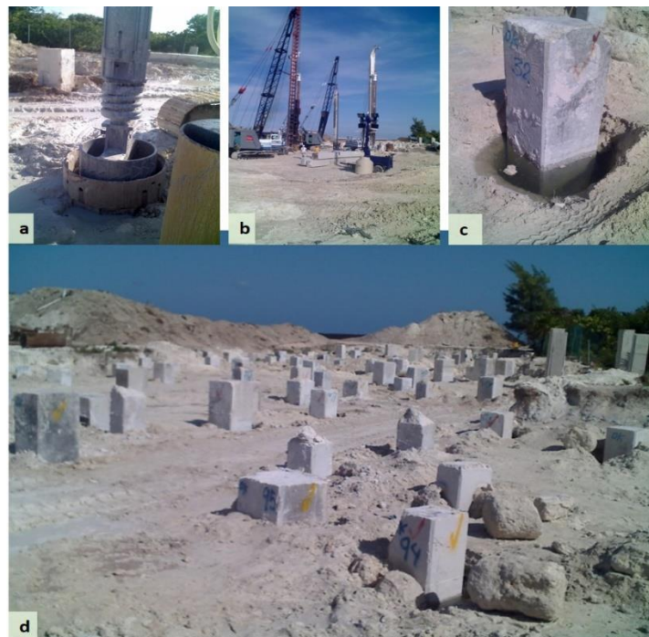
Figura II.14. Etapas del hincado de pilotes o pilas de anclaje. a) Perforación del sitio de anclaje, b) Colocación de pila de concreto, c) vista de una Pila de concreto colocada y d) Conjunto de pilas sobre los que se construirá la red de traveses y contratrases que soportará las edificaciones.
