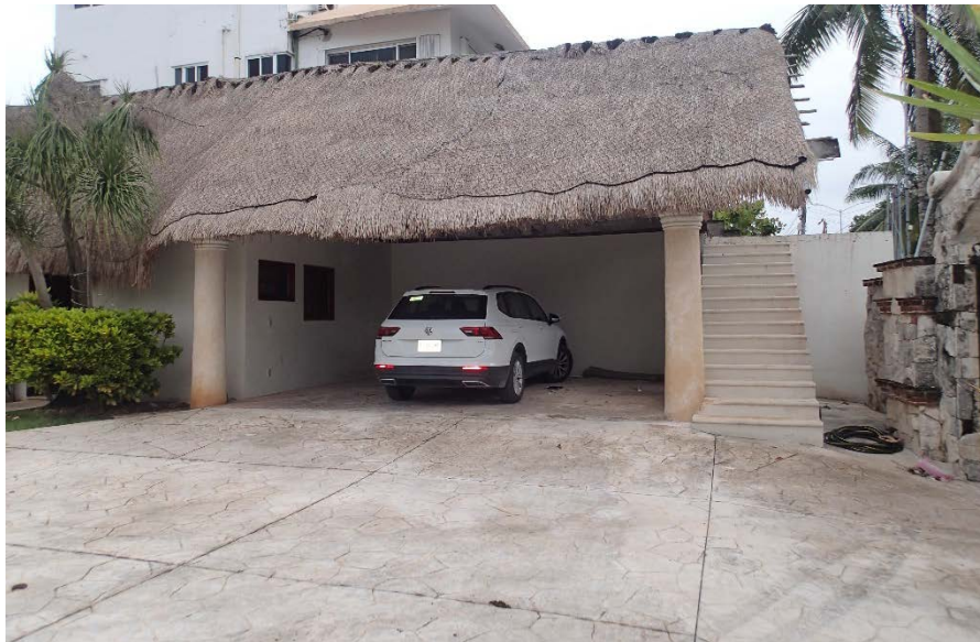
Figura II.2.- Cabaña que funge como estacionamiento
