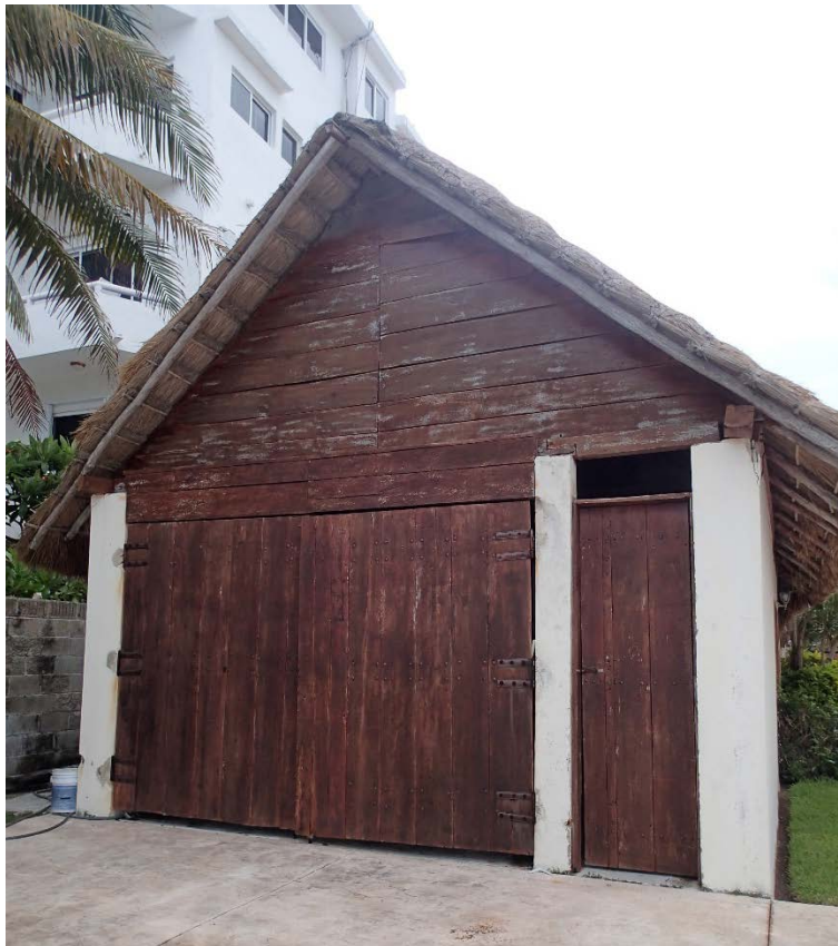
Figura II.4.- Cabaña que funge como estacionamiento
