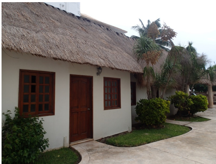
Figura IV.4 Construcción en el predio donde se pretende emplazar el proyecto.
