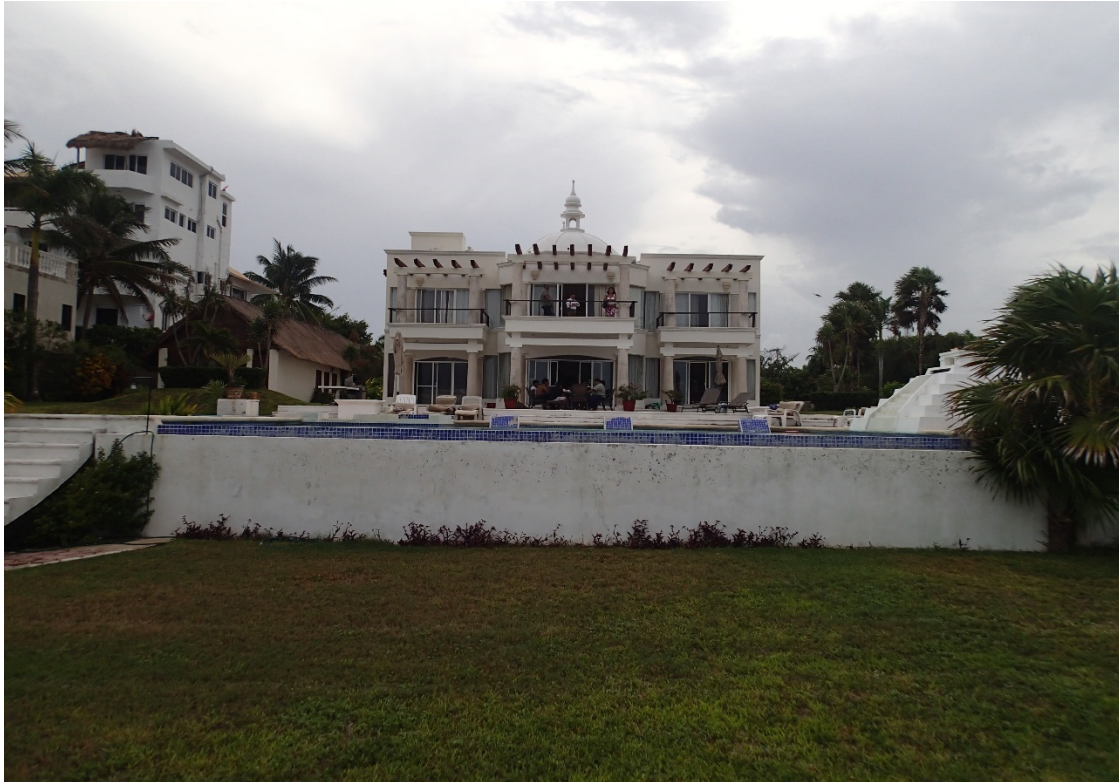
Figura II.9.- Casa habitación con vista desde la parte trasera (ZOFEMAT)
