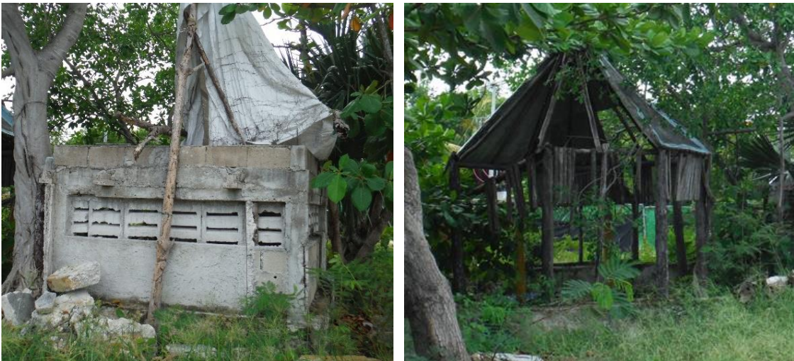
Figura 6.- Construcciones dentro del predio; como se observa estas se encuentran en estado de abandono desde hace varios años, previo a la adquisición del predio por el promotor.
