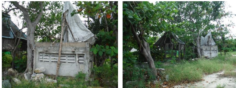
Figura 49.- Estructuras abandonadas que se encuentran en el interior del predio
