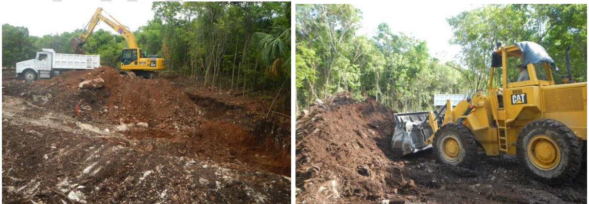
Actividades de despalme (experiencia previa en campo).
