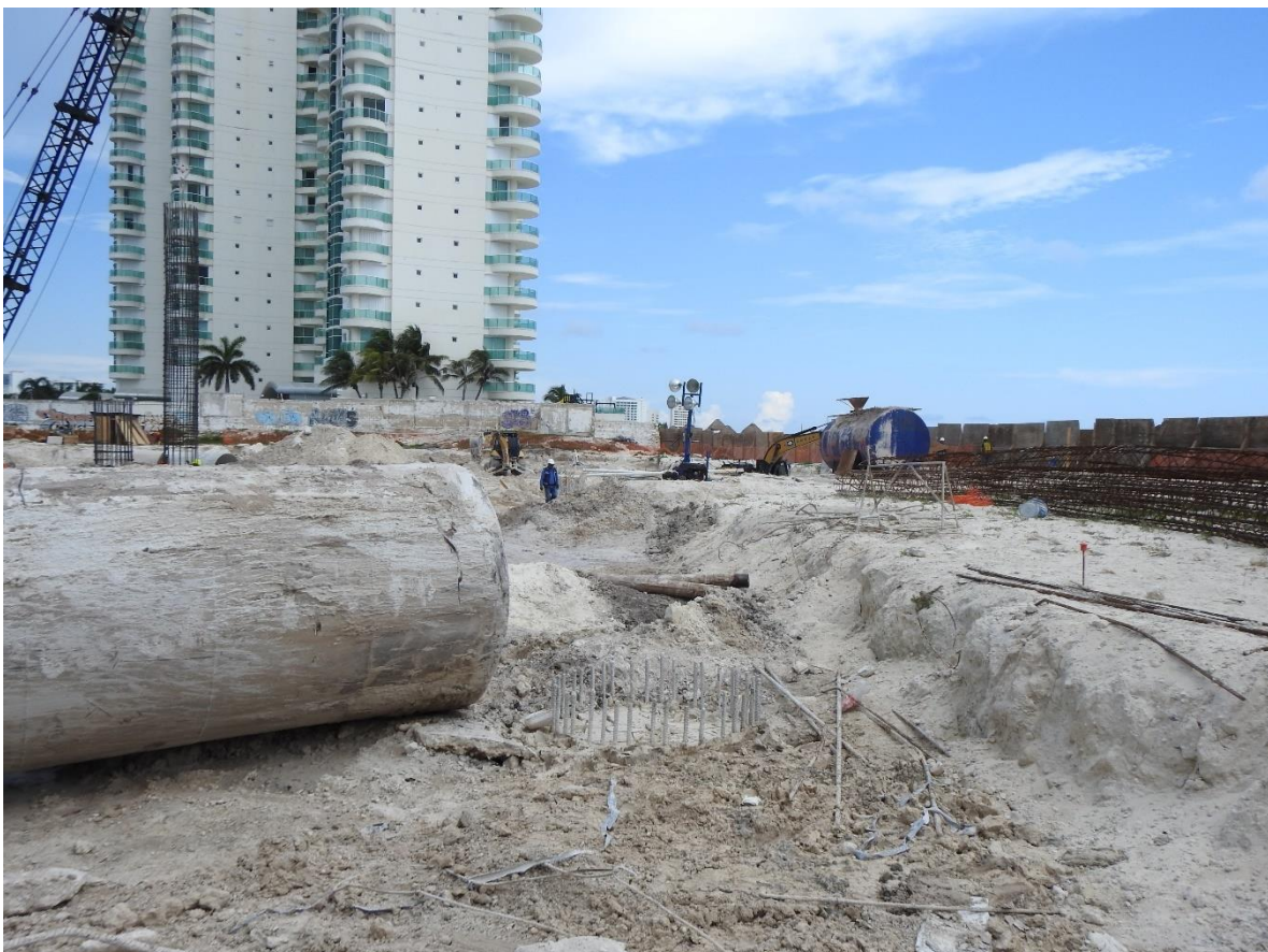
Vista de sur a norte del sitio del proyecto.
