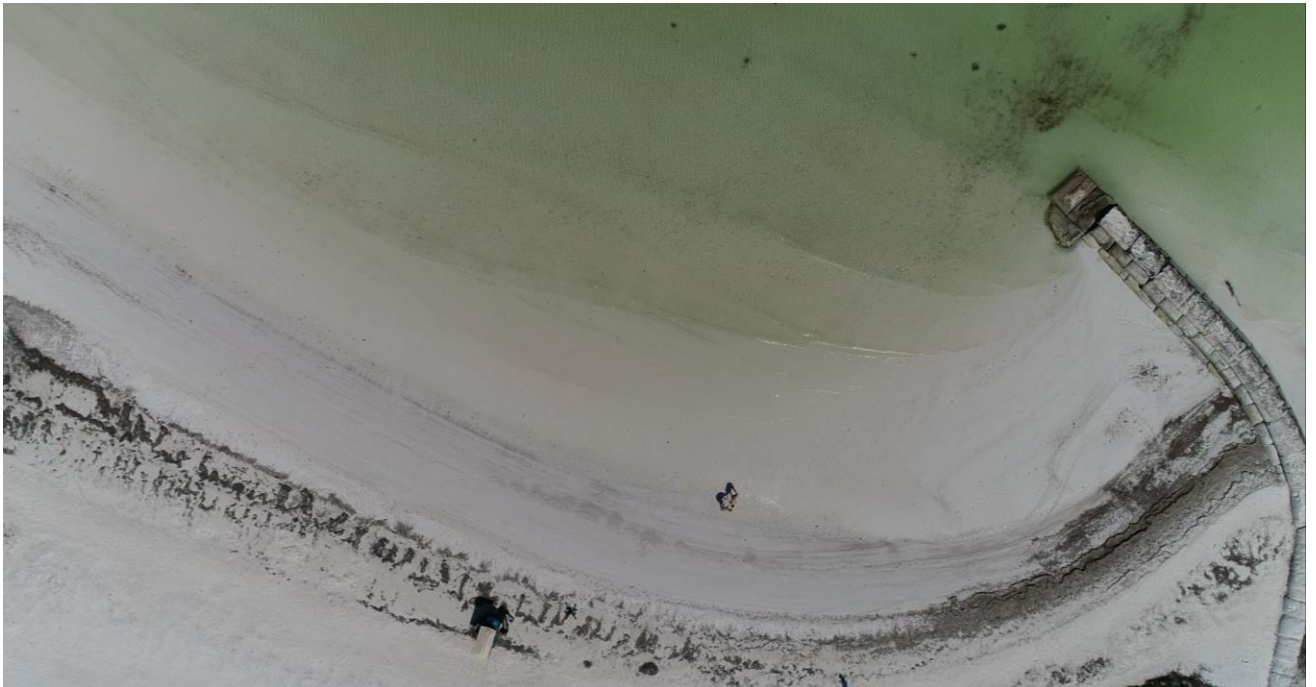
En esta imagen observamos la línea de costa en la zona donde será desplantado el muelle.
