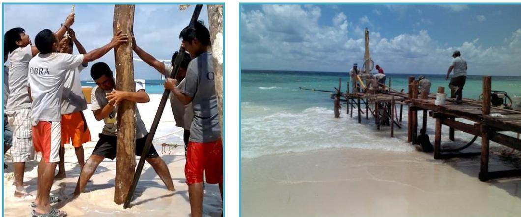
**Figura II\_ 24. Proceso de colocación de los pilotes de soporte del muelle usando chorro de agua a presión en sustrato arenoso y piloteadora en fondo rocoso.**
