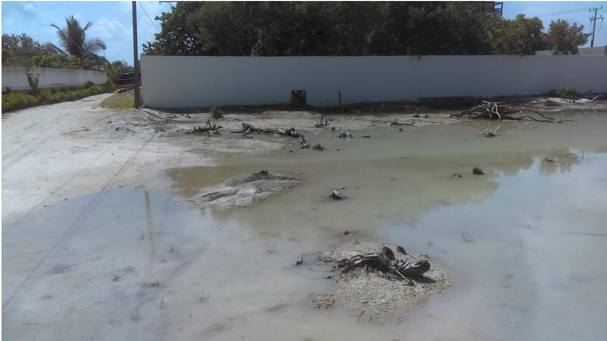
Figura II.8. La limpieza del terreno se realizó de manera manual.
