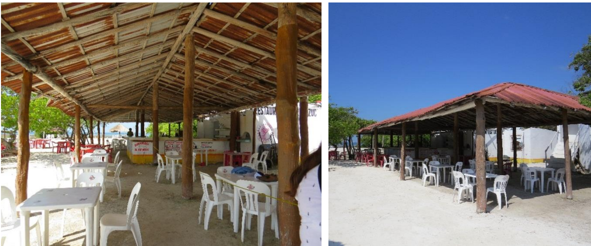
Figura 9. Se muestran algunas de las obras existentes
