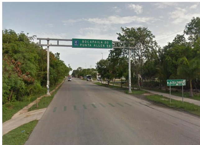
Fotografía IV. 47. Vista de la Carretera estatal Tulum-Punta Allen
