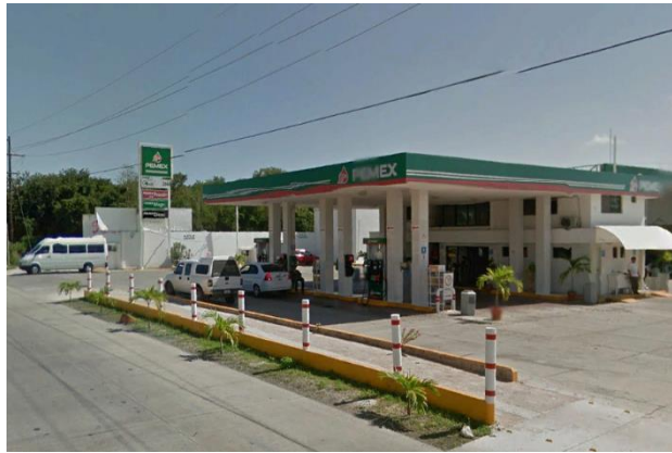
Fotografía IV. 48. Vista de una de las Estaciones de Servicio ubicada sobre la carretera Tulum-Playa del Carmen
