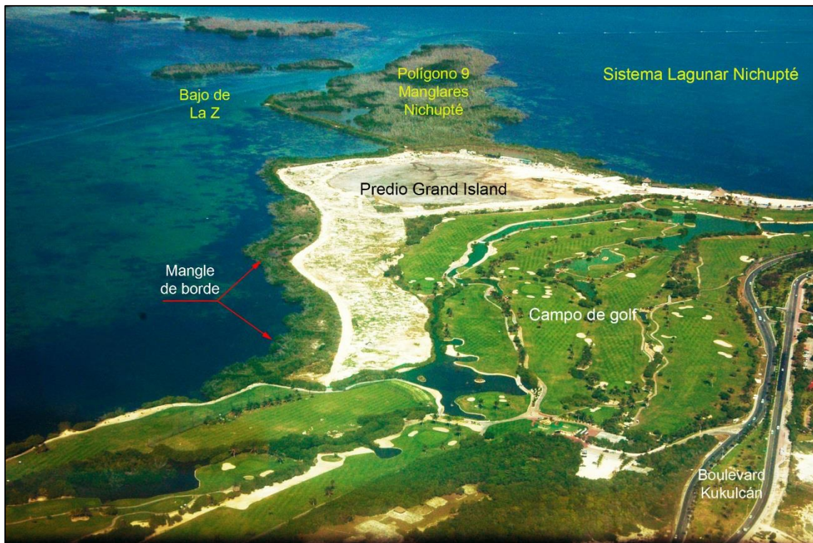
Localización del predio del proyecto Hotel Grand Island Cancún , localizado en las márgenes del Sistema Lagunar Nichupté, en la Zona Hotelera de Cancún, rodeado de manglares y aguas lagunares, así como un campo de golf, tal y como se encontraba en 2010 una vez limpiado el terreno.
