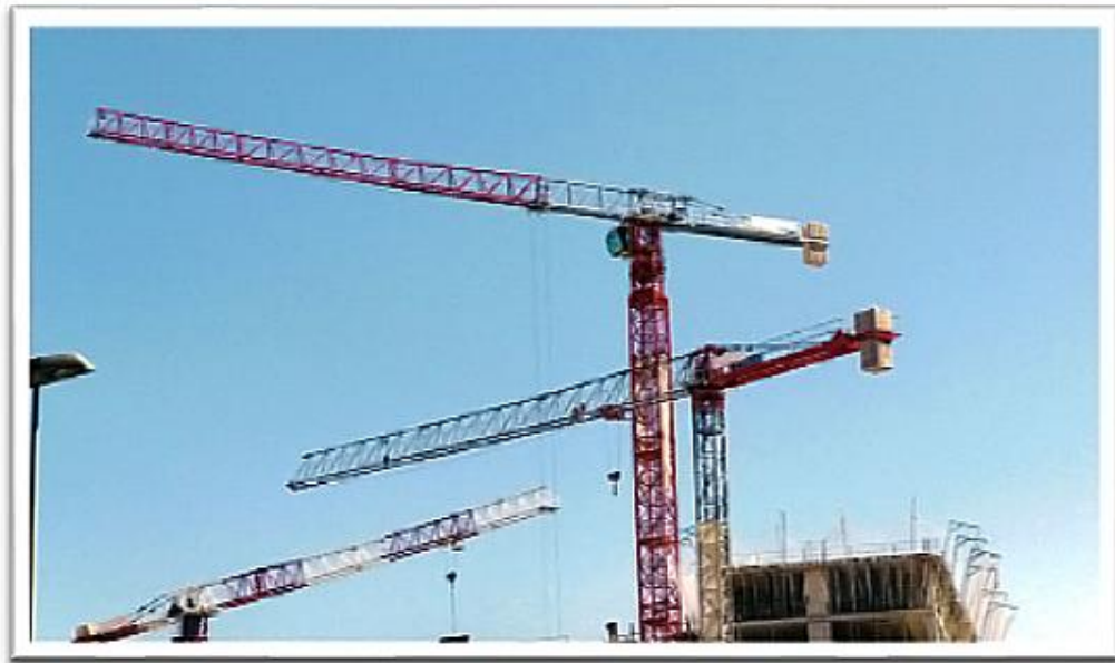
La imagen muestra un ejemplo de las torres grúa para elevación de materiales, que se usarán para armar la estructura y apoyar los trabajos de obra civil.
