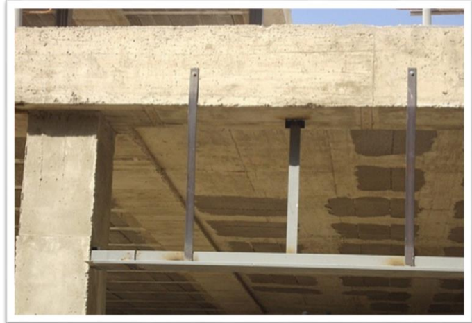
La imagen muestra un ejemplo de perfiles metálicos anclados a estructura para recibir cancelería.
