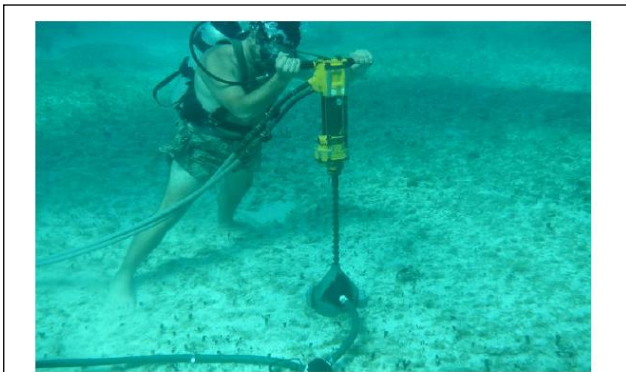
Barrenación por medio de sistema de bombeo anti-sedimentos.
