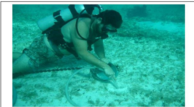
Limpieza de barreno por medio de sistema de bombeo anti-sedimentos.
