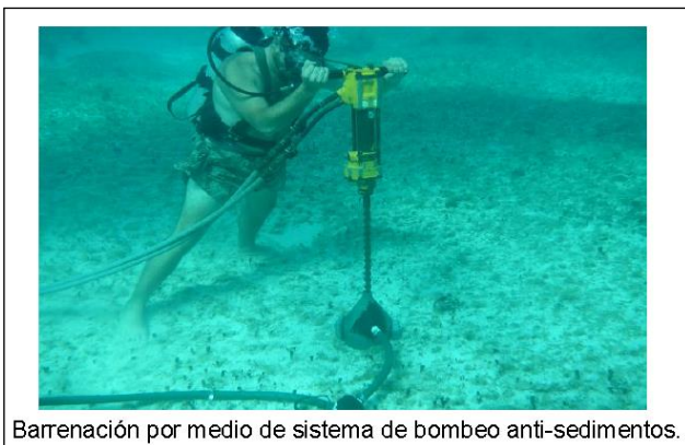
Barrenación por medio de sistema de bombeo anti-sedimentos.
