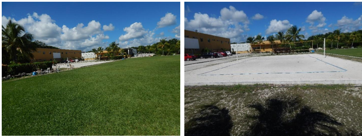
Figura 2. 9. Imágenes de la cancha de voleibol en etapa operativa
