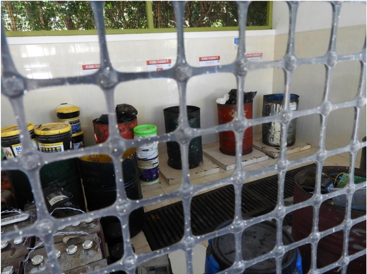
*Interior del almacén de residuos peligrosos existente, con canaleta para la contención de derrames*
