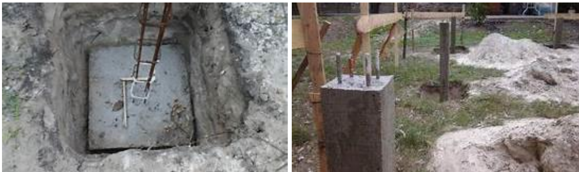
Imagen II-7 Ejemplo de la zapata inferior que sustenta la obra. Se hace evidente la mínima superficie de contacto con el suelo.
