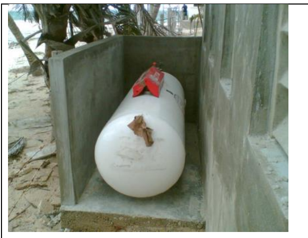
Ejemplo de tanque estacionario de Gas
