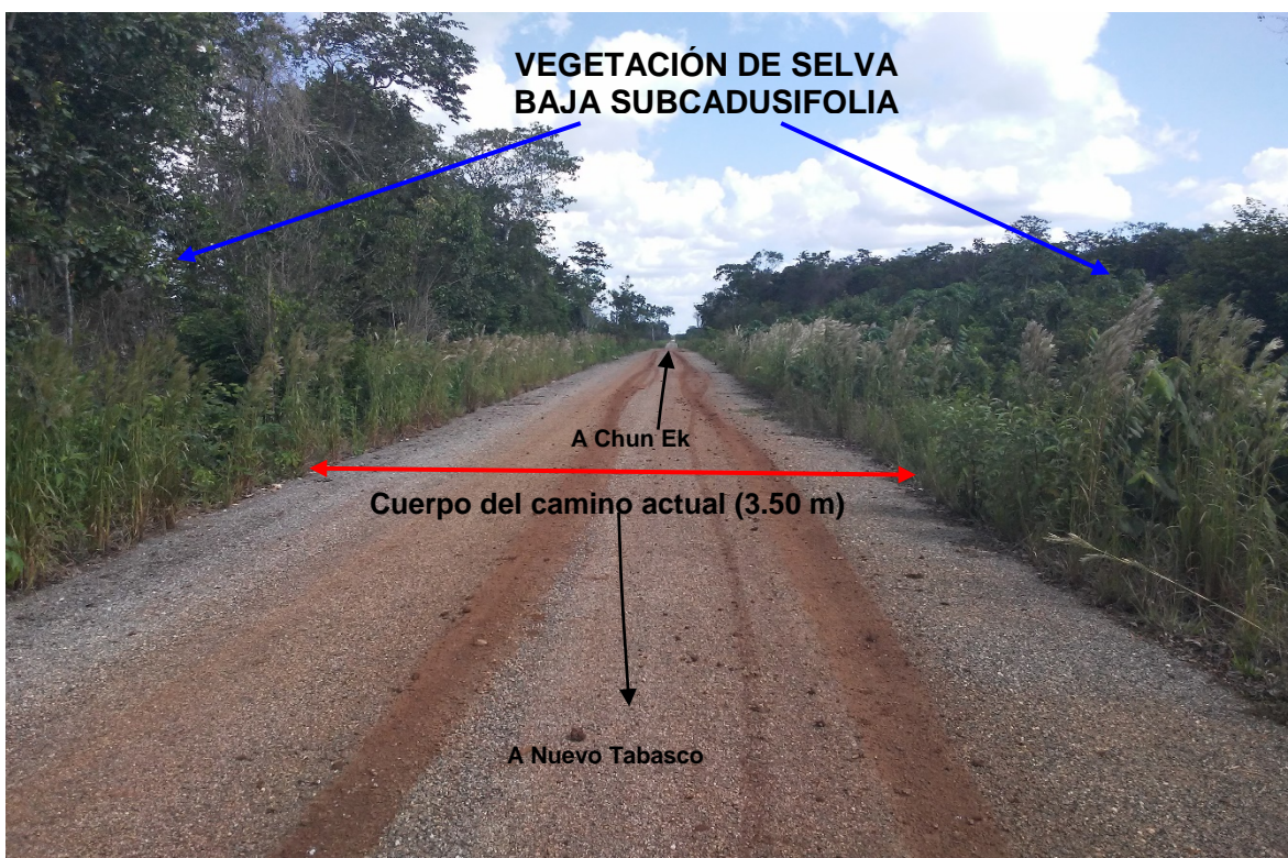
Figura 1.- Vista general del camino actual (tramo pavimentado)
