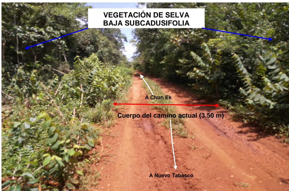
Figura 2.- Vista general del camino actual (tramo de terracería)
