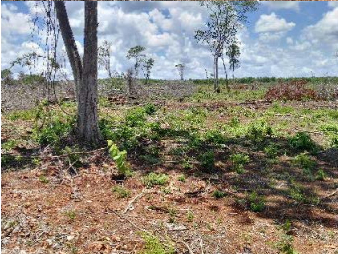
“AMPLIACIÓN Y MODERNIZACIÓN DEL CAMINO NUEVO TABASCO – CHUN EK, CON UNA META DE 16+080 KM EN LOS RESPECTIVAMENTE” MUNICIPIOS DE BACALAR Y HOLPECHEN EN LOS ESTADOS DE QUINTANA ROO Y CAMPECHE”
