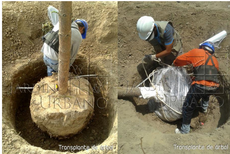
Figura VI-8. Ejemplo de banqueo de árboles y protección de raíces para evitar la desecación.
