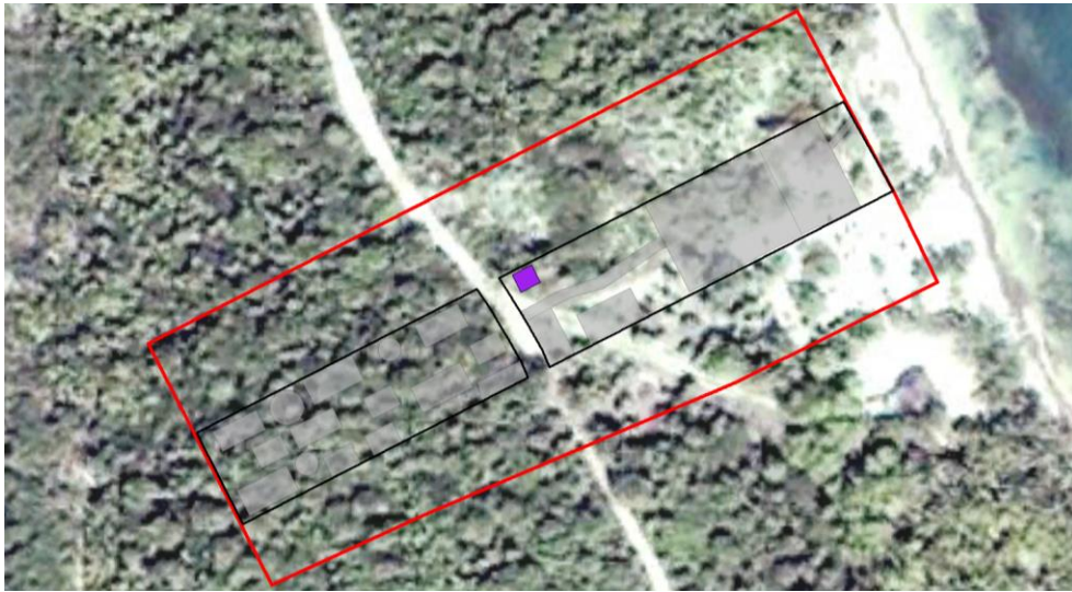
Figura II.16. Ubicación de la caseta de vigilancia.
