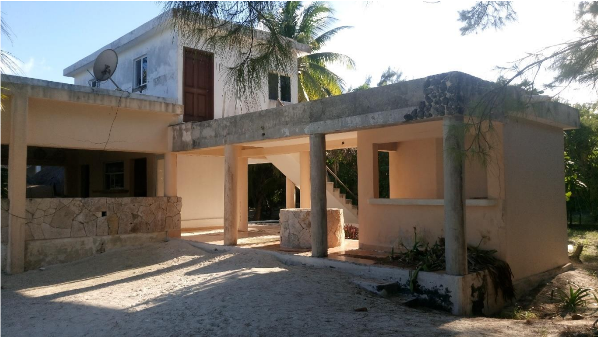
Figura IV.81. Condiciones actuales del predio, en donde se observa la presencia de infraestructura.
