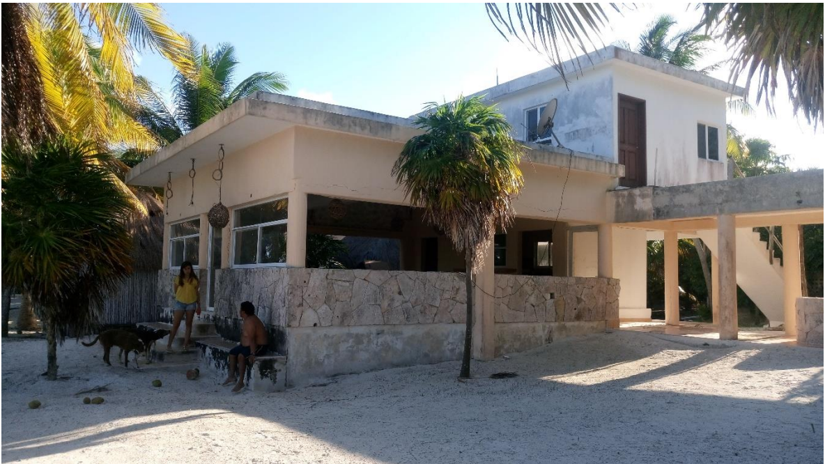
Figura IV.45. Condiciones actuales del área en donde se pretende desarrollar el proyecto.
