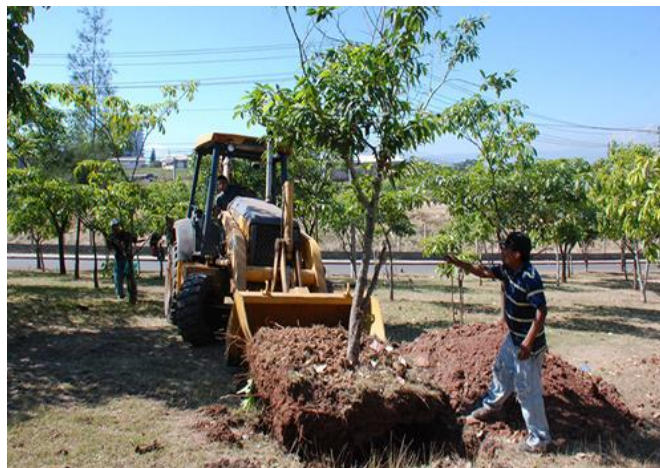
Figura VI-9. Ejemplo de banqueo de árboles con maquinaria.
