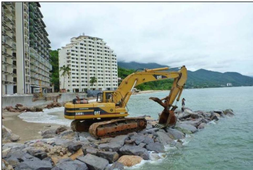
Figura II.20.- Ejemplo de conformación de piedraplén hasta alcanzar el eje de los arrecifes artificiales.
