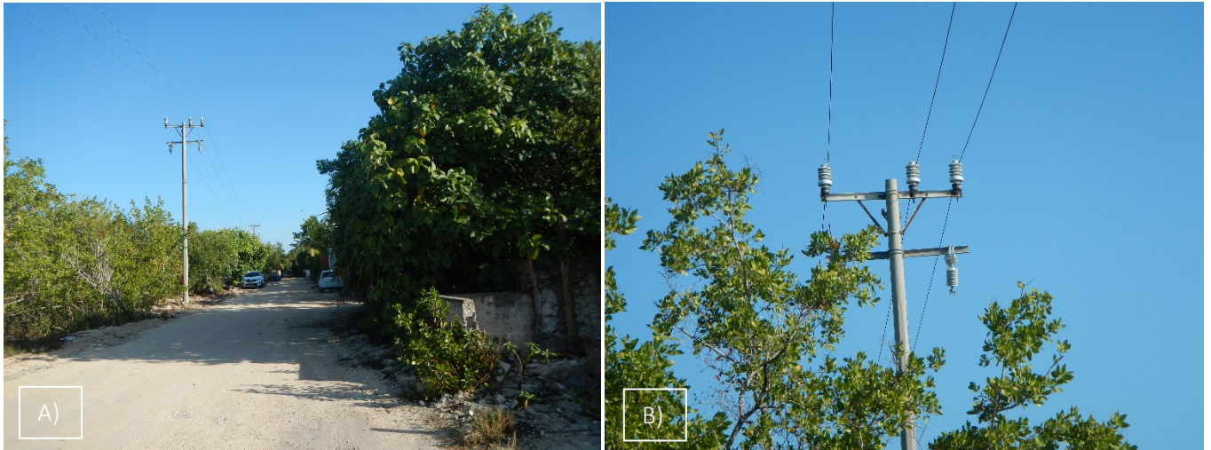
Fotografía 1. Vista panorámica del exterior del predio (a. Urbanización al suroeste) (b. Servicio de alumbrado público y electricidad al frente).
