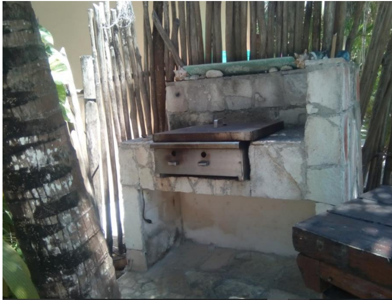
Figura 7. Vista del área de asador del proyecto.
