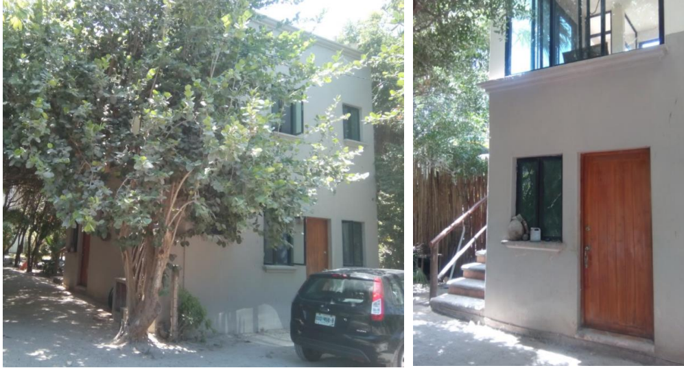
Figura 5. Vista de la casa de servicio del proyecto.
