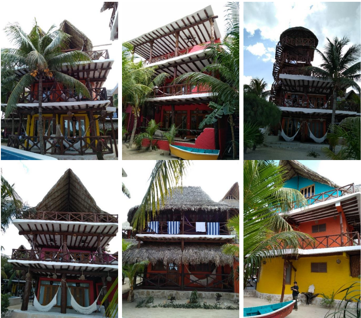
Figura 13. Se muestra aspectos generales de las palapas (edificios)
