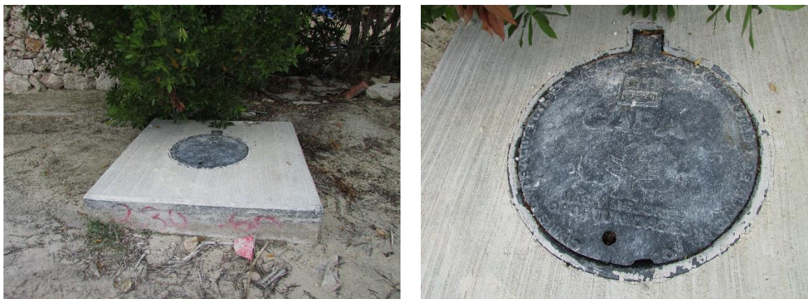
Figura 9. Se muestra la instalación del registro del drenaje ubicado sobre la calle Kuka, colindante al predio del Hotel.
