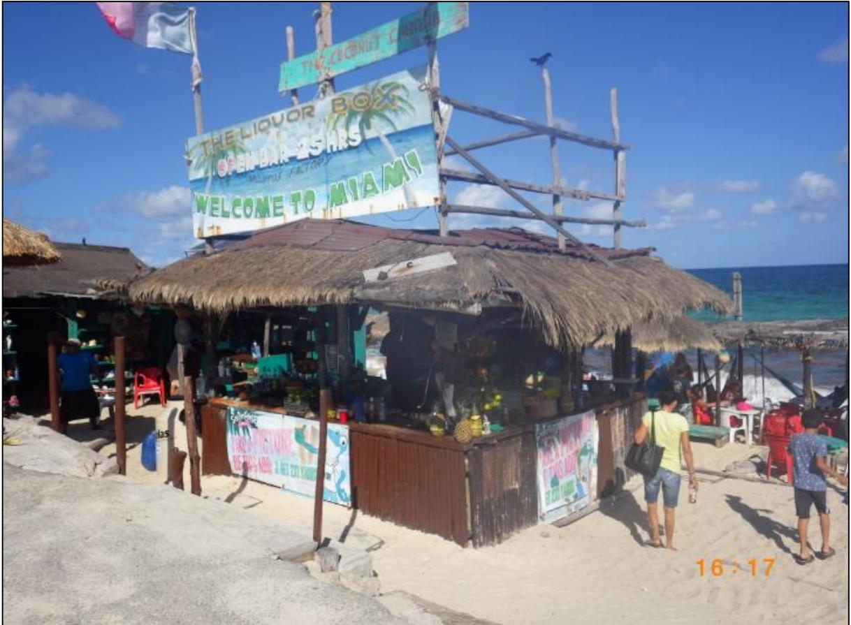
**Pequeño bar**, estructura de madera, con suelo natural (Sustrato arenoso), con paredes de madera cubierta de palizada con altura de 1.20 metros, de techo conformado de lámina, cubierto con zacate, con una superficie de 18.49 metros cuadrados.
