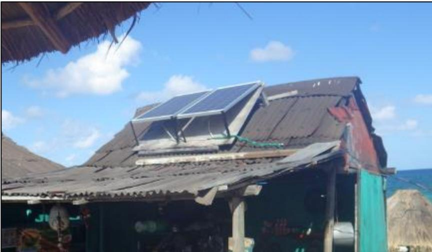
Actualmente en la zona donde se encuentra el club de playa no existe el servicio de energía eléctrica, por lo que el promovente ha instalado dos celdas solares para obtener este recurso. La energía solar es captada por las dos celdas solares y almacenadas en dos baterías. La energía
