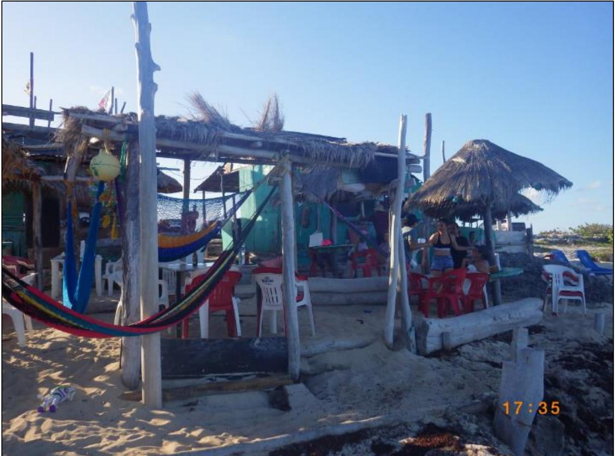
**Area de Hamacas 2**, estructura formada por 6 postes de madera dura de la region a manera de soporte, hincados sobre el sustrato arenoso, sin paredes, 8 postes de madera dura de la region a madera de travesaños, con suelo natural y techo de palma de coco de no reciente colocacion, la cual cuenta con una superficie de 7.84 metros cuadrados.
