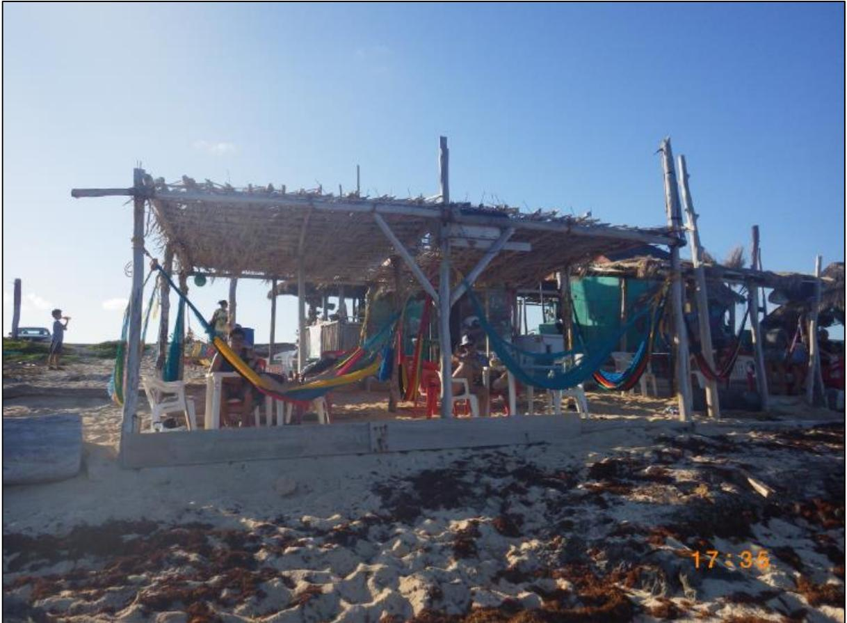
**Area de Hamacas 1**, estructura formada por 8 postes de madera dura de la region a manera de soporte, hincados sobre el sustrato arenoso, sin paredes, 6 postes de madera dura de la region a madera de travesaños, con suelo natural y techo de palma de coco de no reciente colocacion, la cual cuenta con una superficie de 20.25 metros cuadrados.
