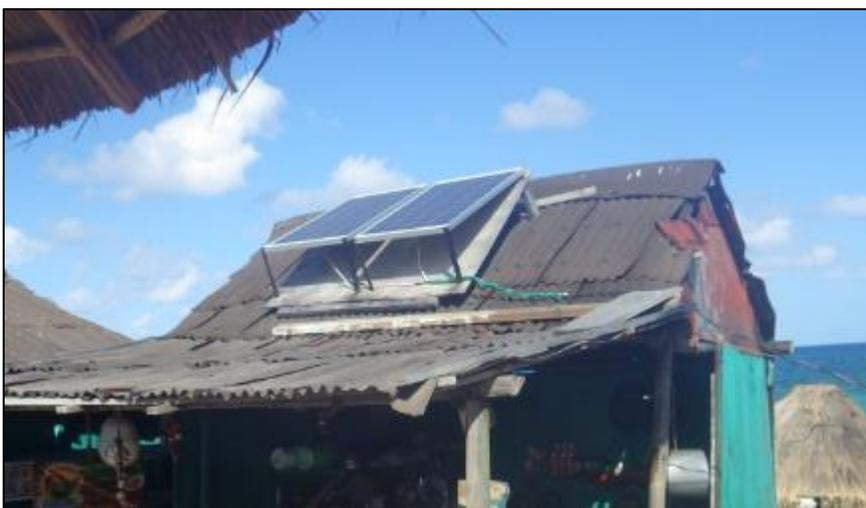
cableado que proporcione el servicio de energía eléctrica por parte de la Comisión Federal de Electricidad, por lo que el promovente instalo un sistema alterno generador de energía. El sistema instalado son dos celdas solares aprovechando la energía del sol, con esta medida se evitan
