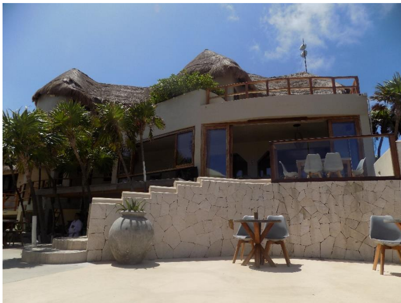
Figura VIII. 2 Fachada del interior del Hotel
