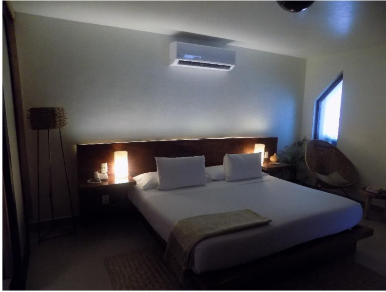
Figura VIII. 3 Interior cuarto planta baja
