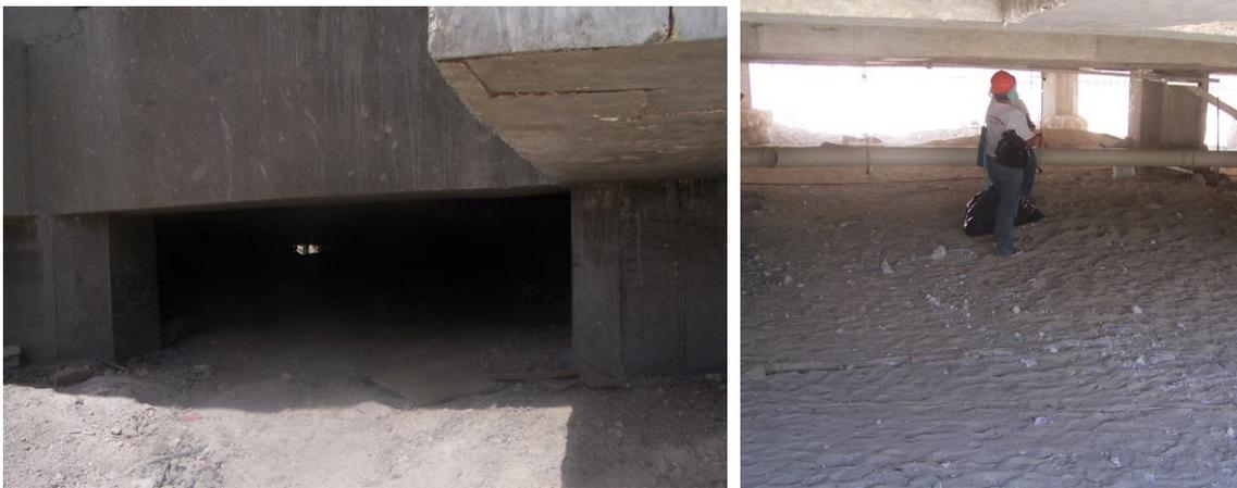
Por lo antes dicho, el método constructivo planteado en el capítulo II de esta MIA-P permite inferir que, por el hincado de 473 pilas, sobre las que se pretende la construcción de una plataforma elevada en la que se insertarán los módulos hoteleros y su infraestructura, así como por la conservación de áreas verdes, que implican el 60.4% del terreno, el proyecto mantendrá los flujos superficiales y subterráneos del sistema geohidrológico.
