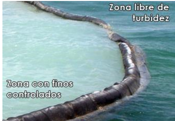
Figura 7. Se muestra a manera de ejemplo el funcionamiento de la malla antidispersión.
