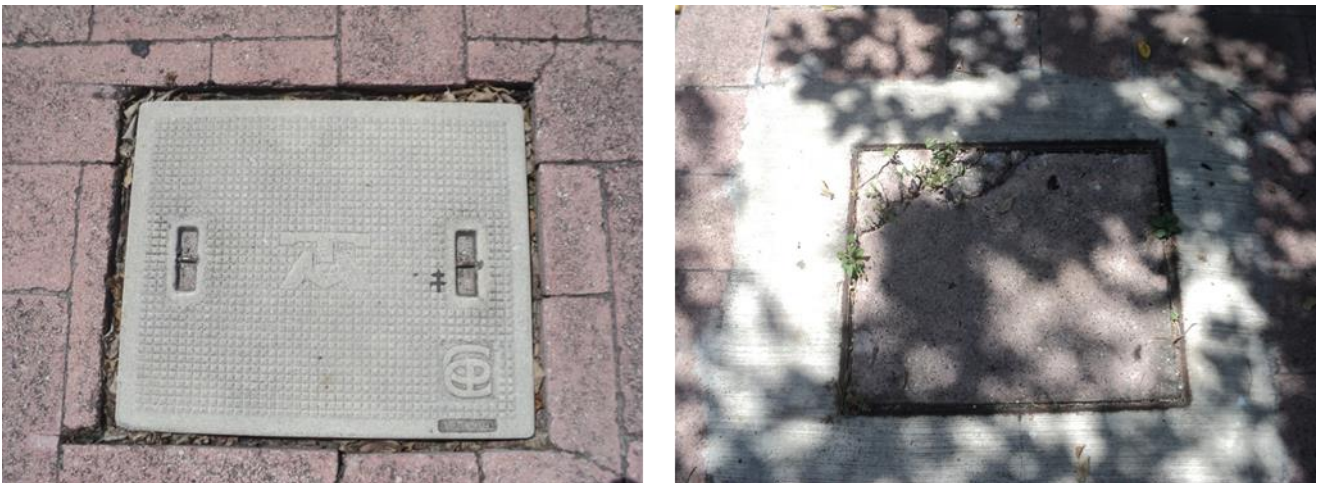
Figura II.7. Registro de telefonía y energía eléctrica establecido en el predio.
