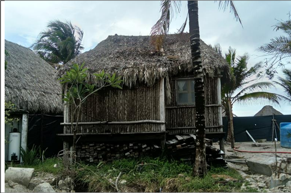
Imágenes del proceso de piloteo en la zona ocupada previamente por las cabañas preexistentes.
