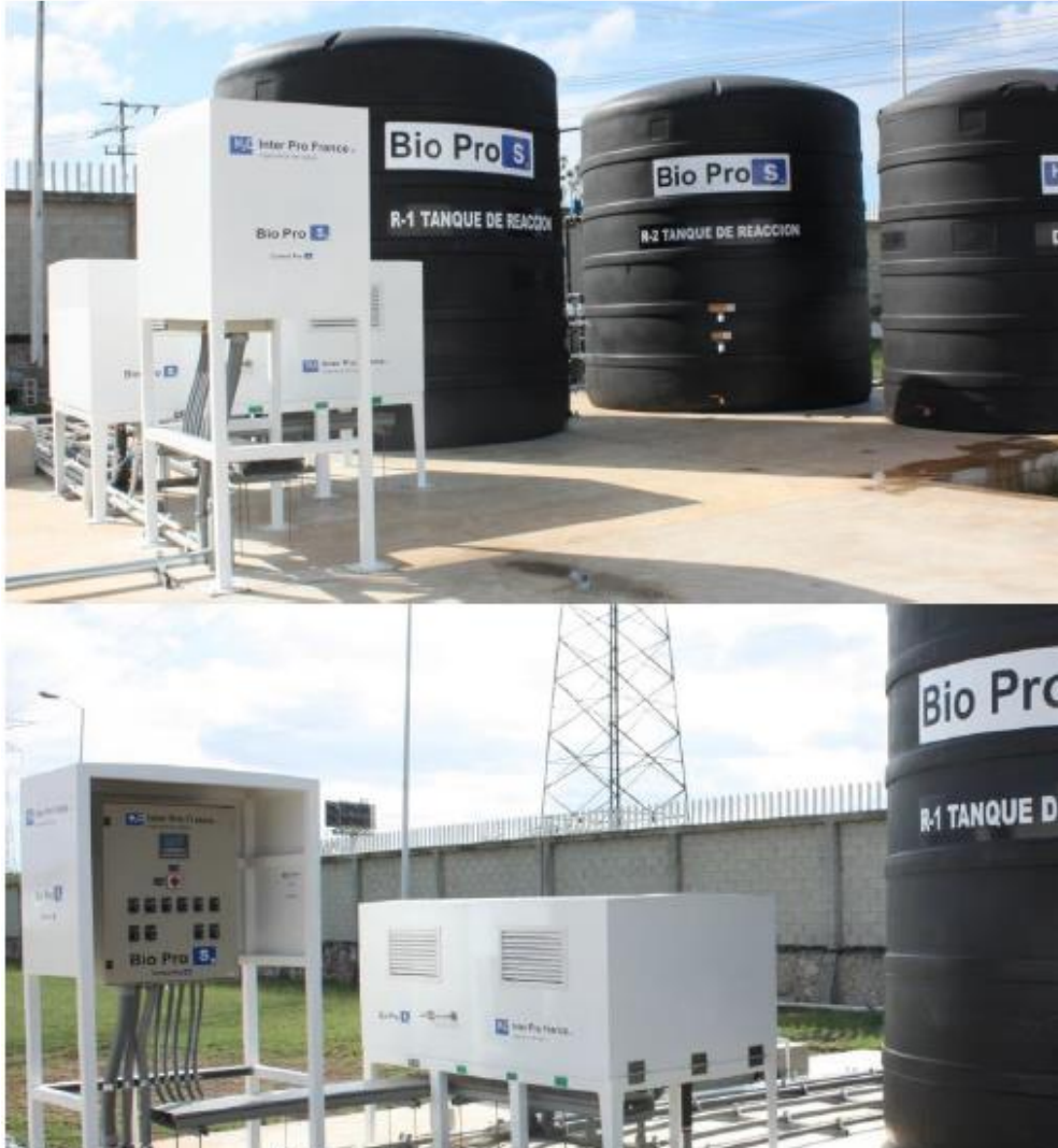
Planta de tratamiento para aguas residuales Bio Pro S®, cuyo funcionamiento permite el tratamiento biológico secuencial de aguas residuales.
