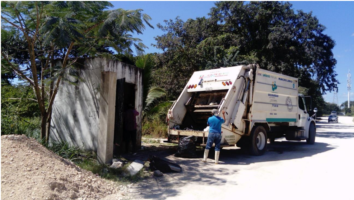
Cuarto para el acopio temporal de residuos sólidos urbanos, con fácil acceso al sistema Municipal de recoja de residuos sólidos urbanos.
