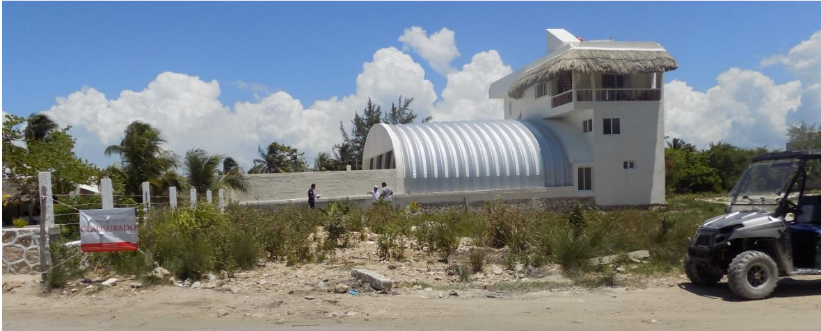
IMAGEN 4 CLAUSURA DEL PREDIO, DERIVADO DE PROCEDIMIENTO ADMINISTRATIVO DE LA PROFEPA.
