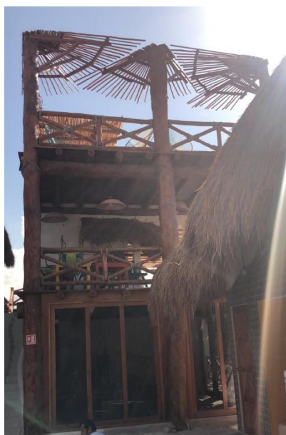
Figura II.6. Bungaló en proceso de construcción en el polígono del proyecto.
