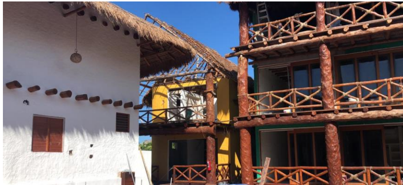
Figura III.3. Obra existente con una altura aproximada de 10.80.
