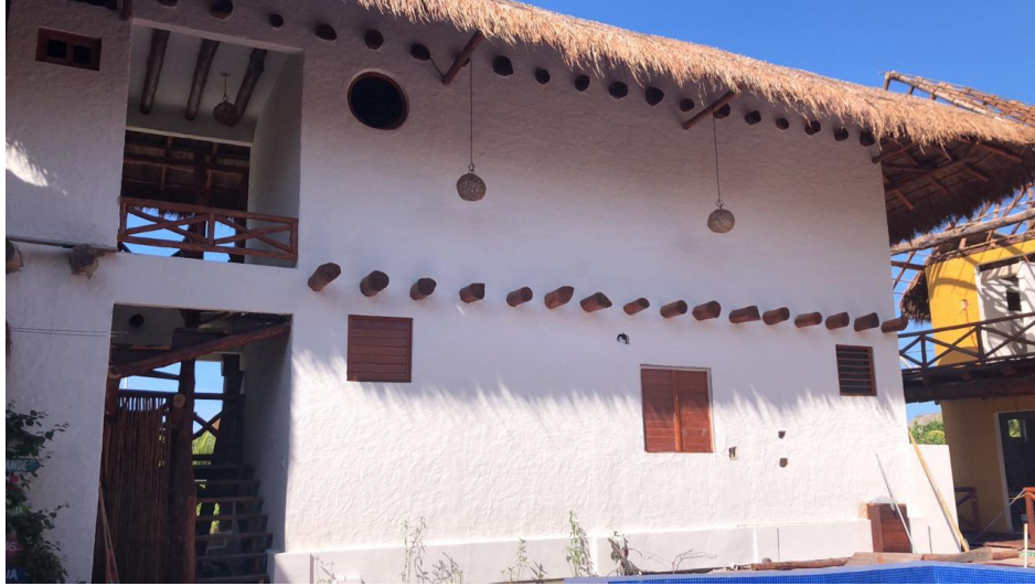
Figura II.7. Bungaló en proceso de construcción en el polígono del proyecto.
