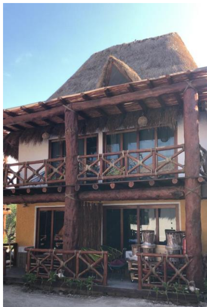
Figura II.5. Bungaló en proceso de construcción en el polígono del proyecto.
