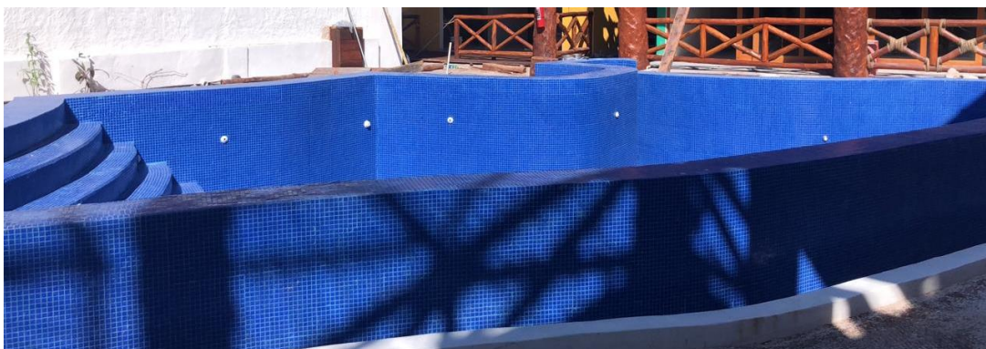
Figura II.8. Alberca en proceso de construcción en el polígono del proyecto.
