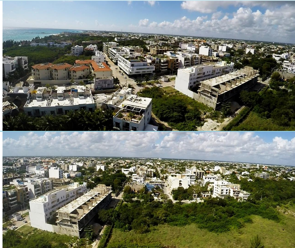
Figura 18. Vista de los asentamientos humanos del sistema ambiental ubicados al poniente de la carretera federal 307.
