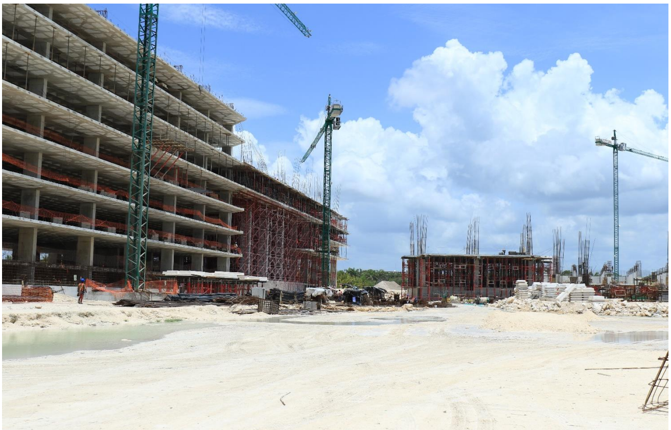
Figura 8. Obras en proceso constructivo al interior del predio.
