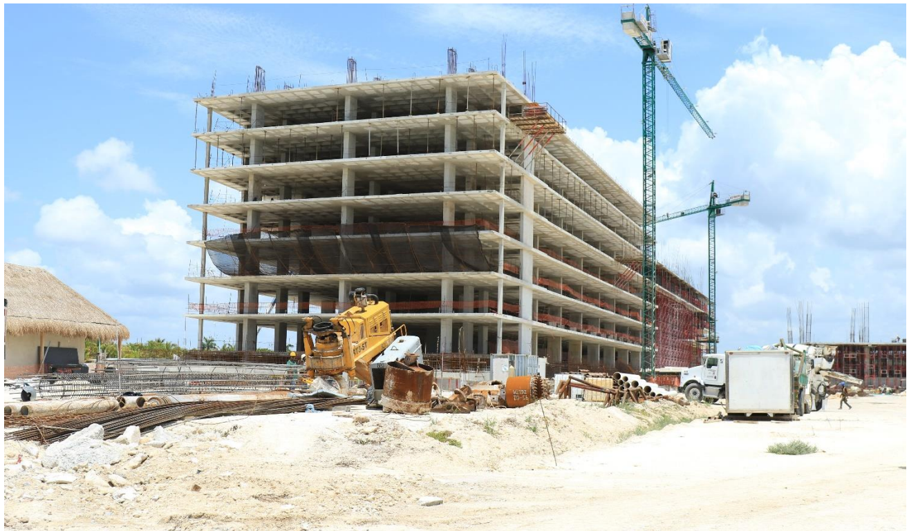
Figura 9. Obras en proceso constructivo al interior del predio.
