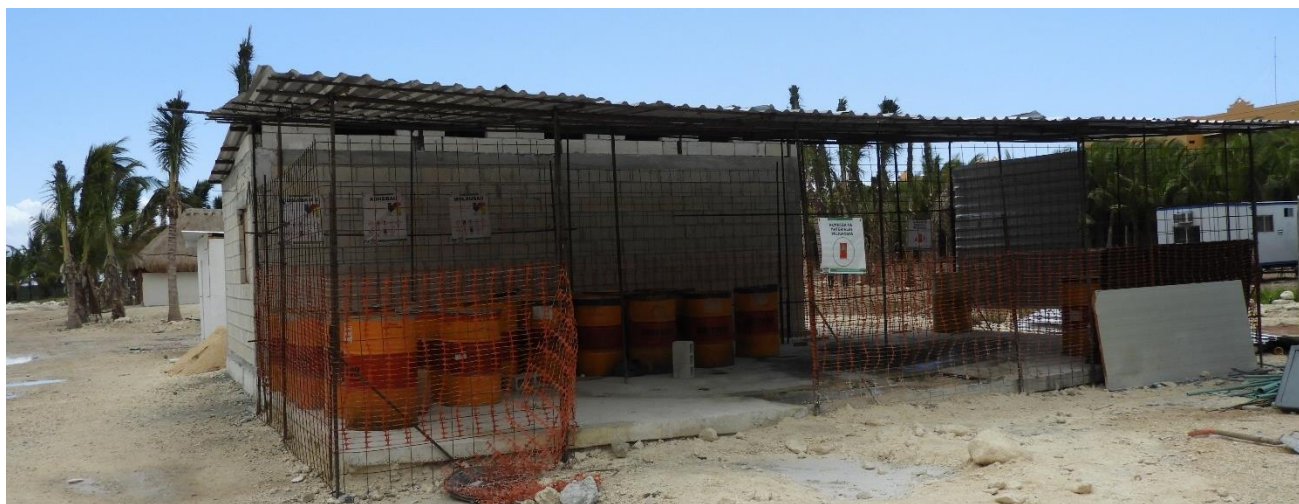
Figura 6. Almacén de residuos peligrosos instalado dentro del predio.
