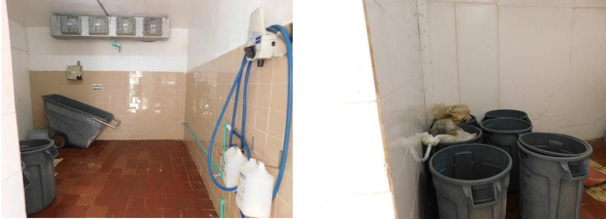
Figura 21. Cámara húmeda donde se almacenan de forma temporal los residuos orgánicos, que se mantiene con refrigeración para reducir el tiempo de descomposición y los malos olores, hasta que son enviados al sitio de disposición final
