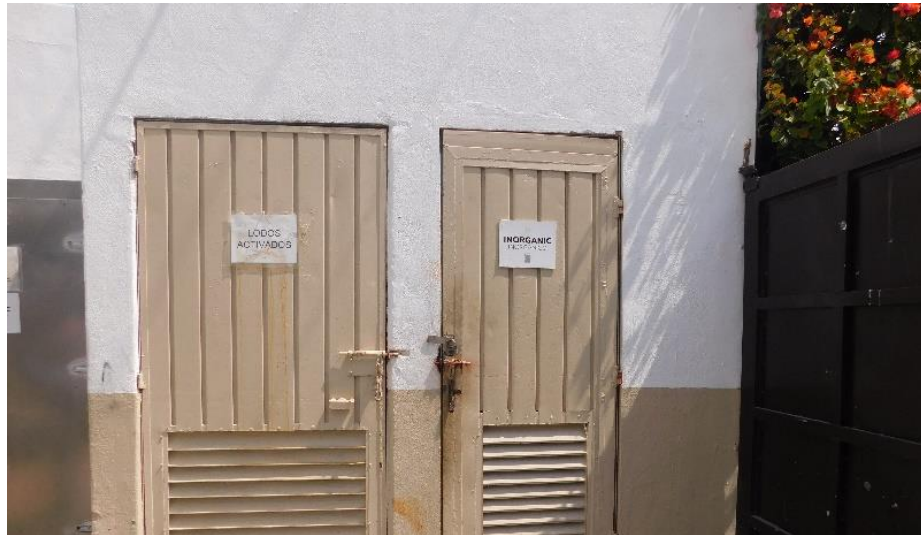
Figura 19. Cámara de residuos de manejo especial, como los lodos activados.
