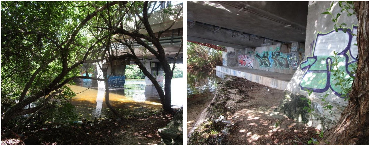
Figura 6. 9. Estado actual del Puente Canal Nizuc.
