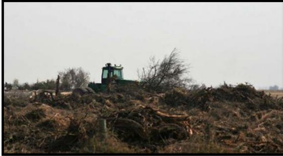
FIG.2.18 EJEMPLO DEL AMONTONAMIENTO DEL MATERIAL RESULTANTE DEL DESMONTE
