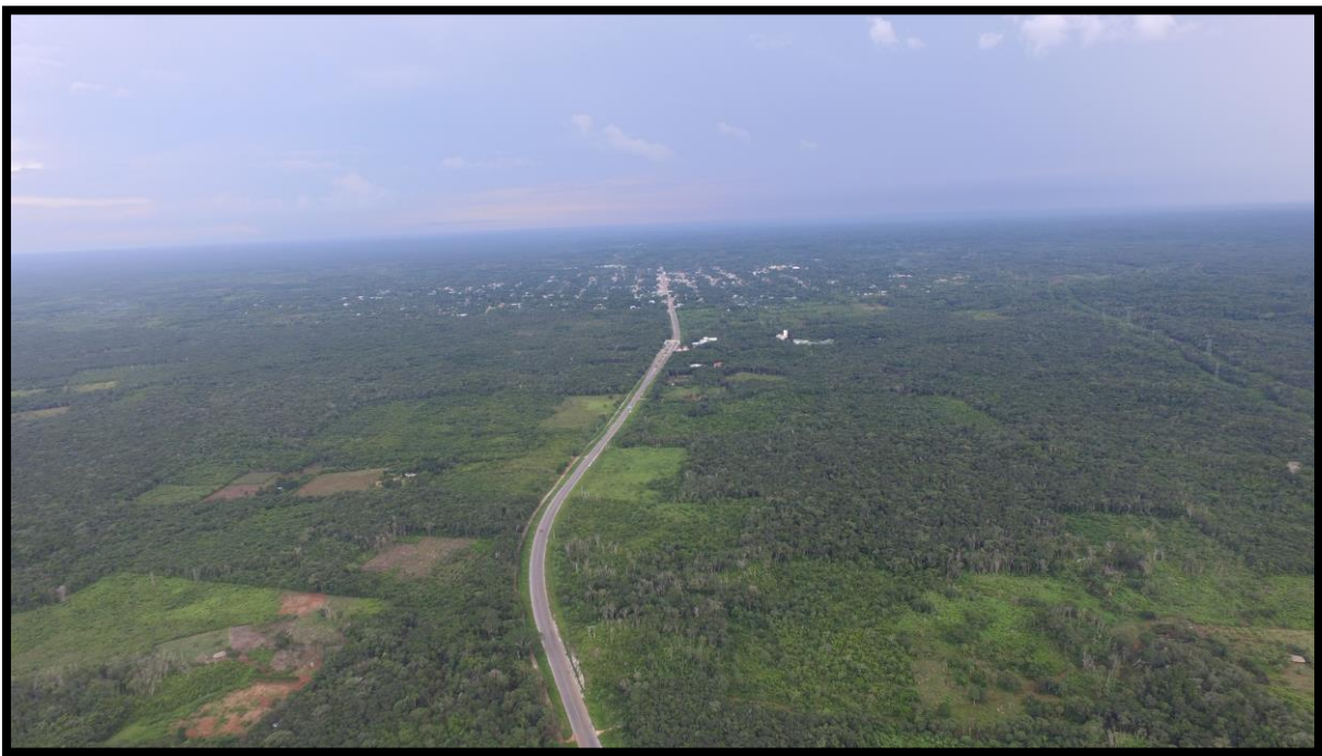
FIG.4.28 VISTA DE LA VEGETACIÓN A LO LARGO DEL PROYECTO
