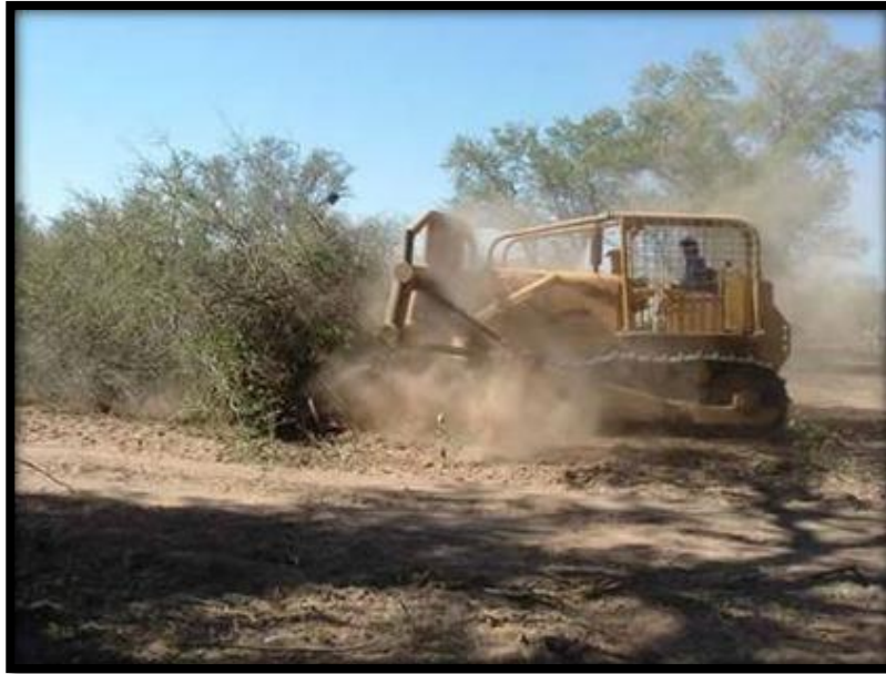
FIG.2.16 EJEMPLO DE UNA MAQUINA RETIRANDO LOS RESIDUOS VEGETALES
