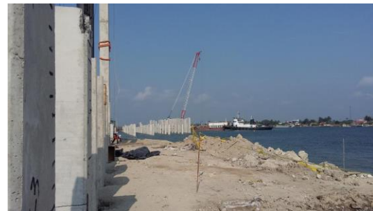
Figura II-31. Hincado de pilotes prefabricados para la extensión de la pasarela.
