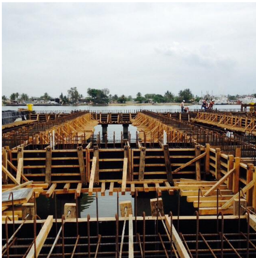
Figura II-34. Habilitado de acero y cimbrado de viga cabeza.
