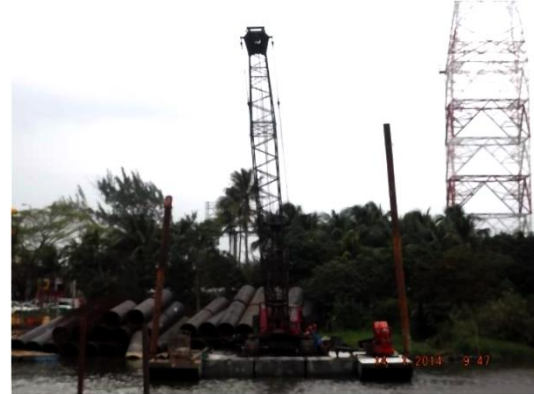
Figura II-12. Maquinaria Torre Grúa para la guía e hincado de los elementos constructivos de la pila.
