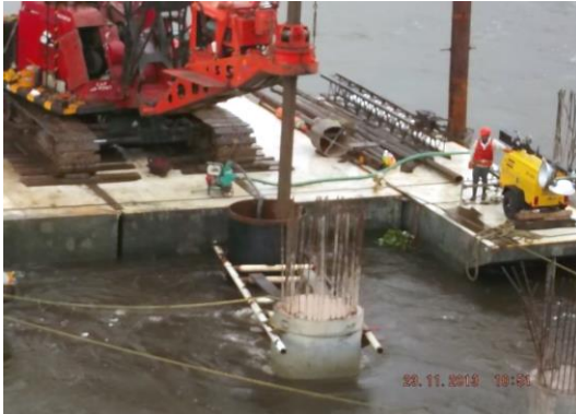
Figura II-21. Hincado del armado de acero.
