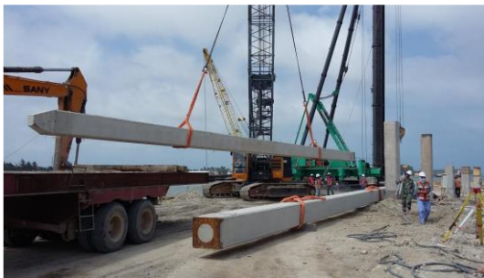
Figura II-30. Hincado de pilotes prefabricados para la extensión de la pasarela.
