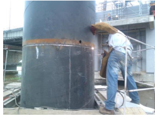
Figura II-16. Unión del ademe con escantillón.
