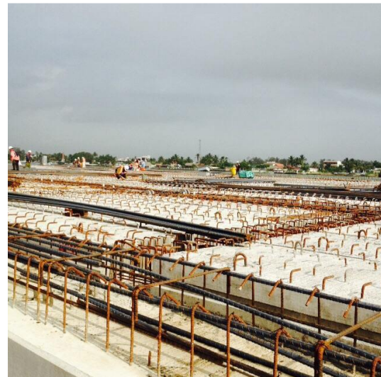
Figura II-35. Conformación y montaje de tableros prefabricados.
