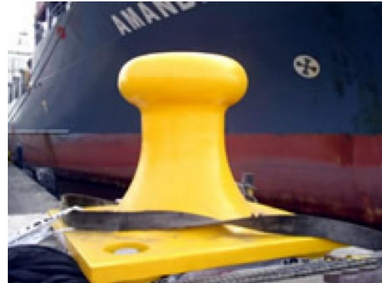
Figura II-26. Instalación de bita de amarre de 100 Toneladas.
