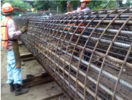
Figura II-17. Habilitado de acero para las pilas.
