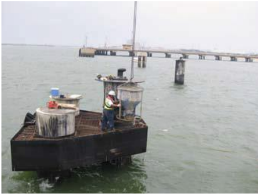
Figura II-25. Colado de plataforma de duque de alba.
