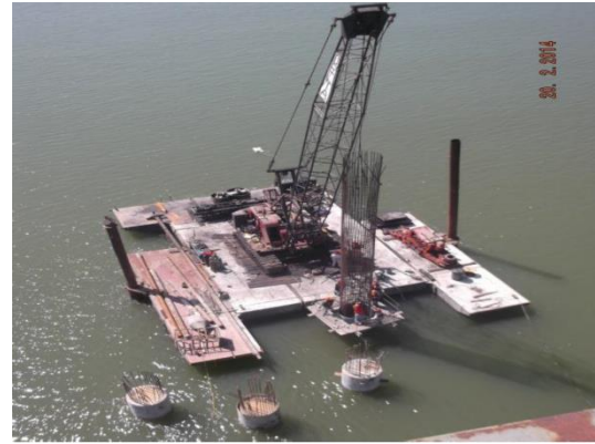
Figura II-20. Hincado del armado de acero.
