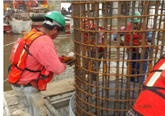
Figura II-22. Hincado del armado de acero.
