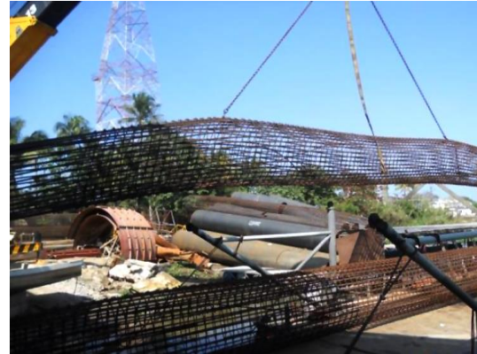
Figura II-18. Levantamiento del armado de acero con grúa de 175 Ton.
