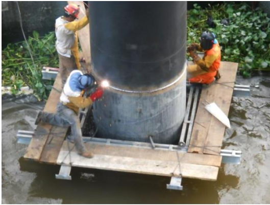
Figura II-15. Soldadura para unión del ademe con escantillón.
