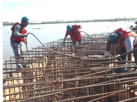
Figura II-24. Habilitado de acero y cimbrado de superestructura.
