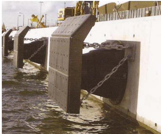
Figura II-27. Instalación de defensa.
