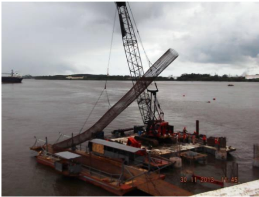
Figura II-19. Levantamiento del armado de acero con grúa.
