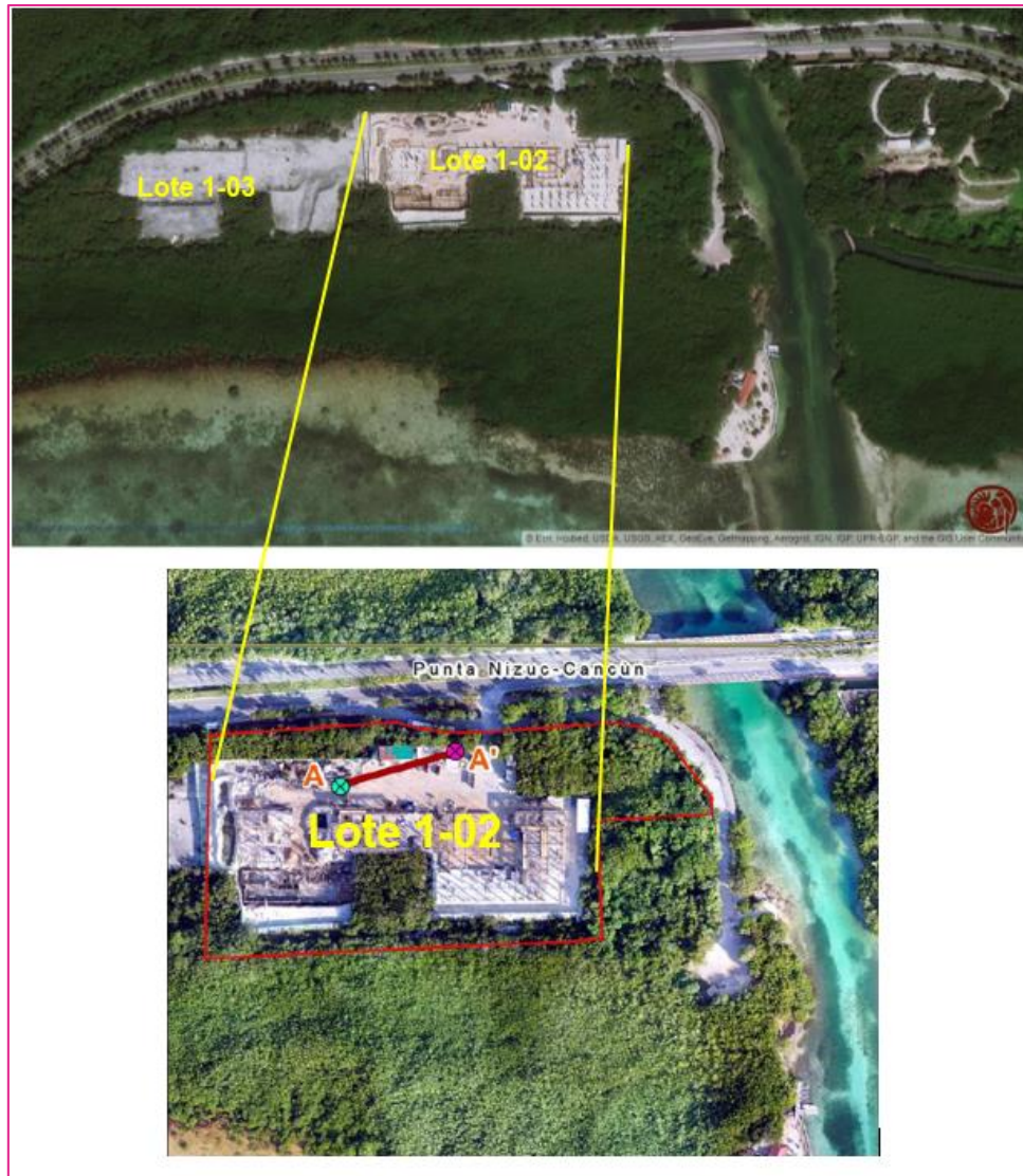
FIGURA 7. SE OBSERVA EN LA IMAGEN DE ARRIBA 1 , CON LAS PLATAFORMAS DE MATERIAL PÉTRICO DE ACUERDO A LA AUTORIZACIÓN ORIGINAL COMO CONDOMINIOS, EN LA IMAGEN INFERIOR EL LOTE 1-02 EL HOTEL AUTORIZADO. (IMAGEN TOMADA CON DRON, JUNIO DEL 2019).
