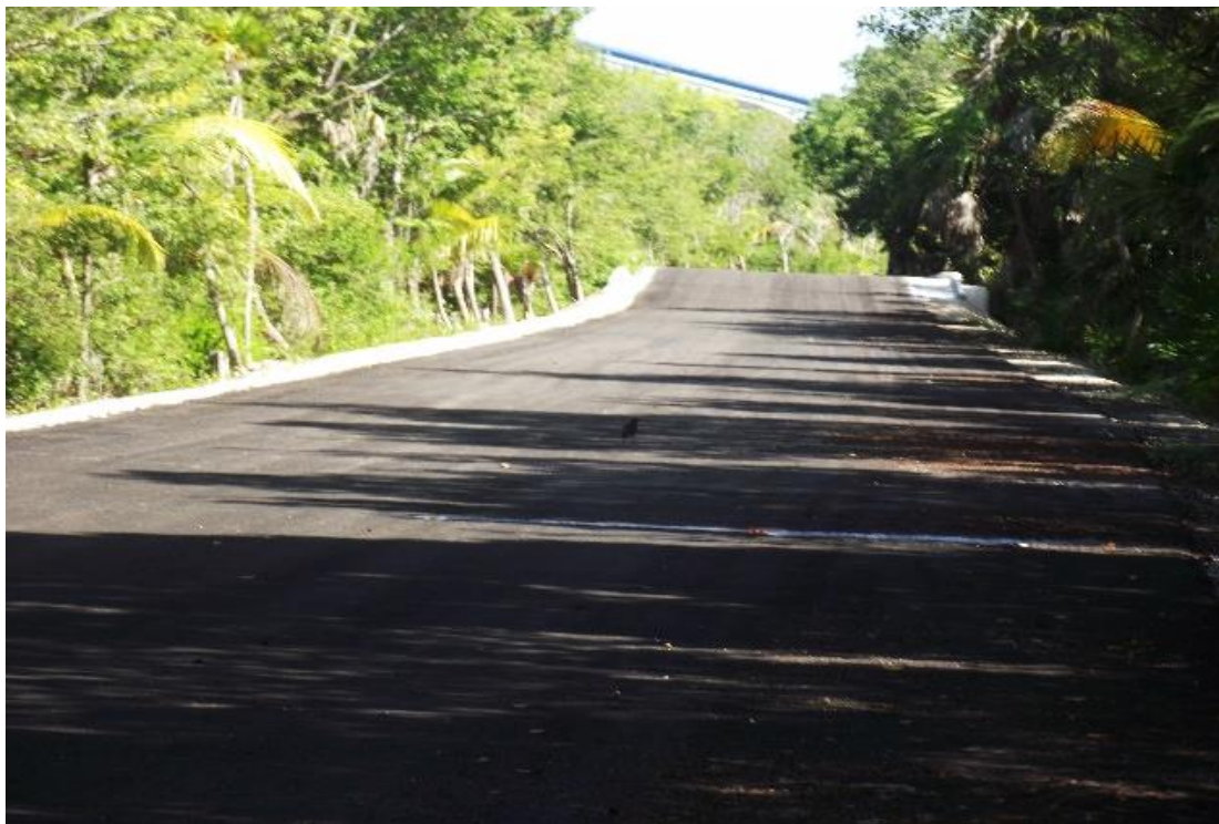
Figura 30. Camino que atraviesa el predio del proyecto.
