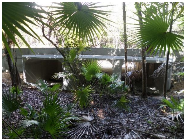
Figura 4. Vista de uno de los pasos de agua y fauna de la vialidad existente.
