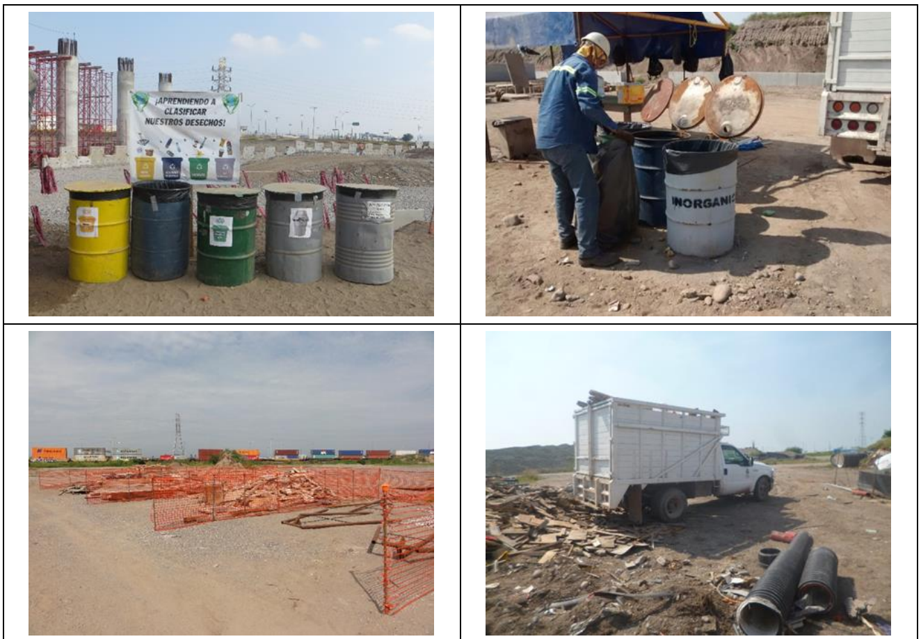
Figura II-10. Ejemplo del acondicionamiento y diferenciación y colecta de residuos sólidos urbanos y de manejo especial en proyectos en construcción.
