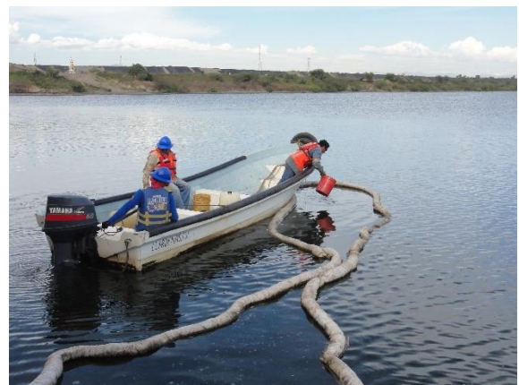
Recuperando residuos encapsulados en la barrera absorbente en cuerpo de agua.
