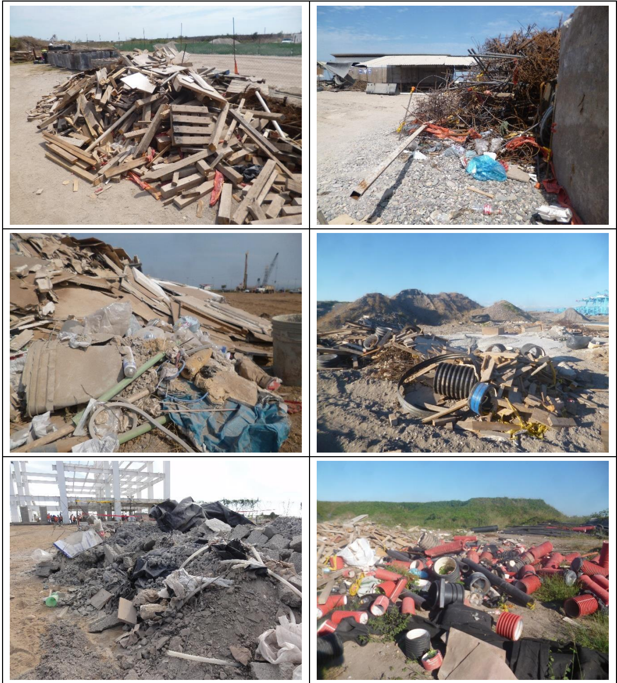
Figura II-14. Ejemplo de evidencias del mezclado durante la disposición temporal de residuos de manejo especial durante la etapa de construcción.
