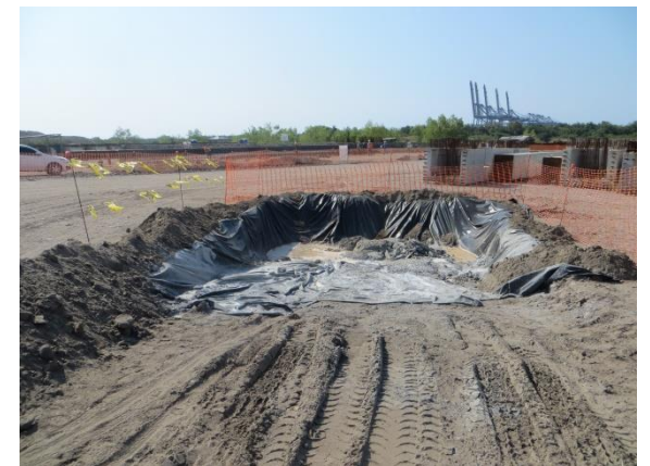
Habilitado de área para la disposición temporal de residuos de mezcla.
