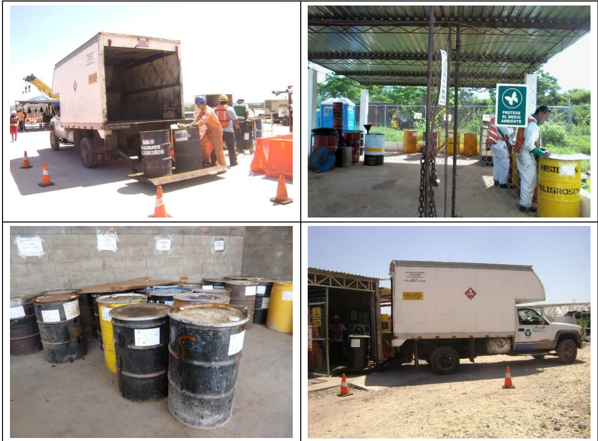
Figura II-18. Ejemplos de la prevención de la generación y manejo de los residuos peligrosos durante las etapas de preparación y construcción de proyectos de obra civil.
