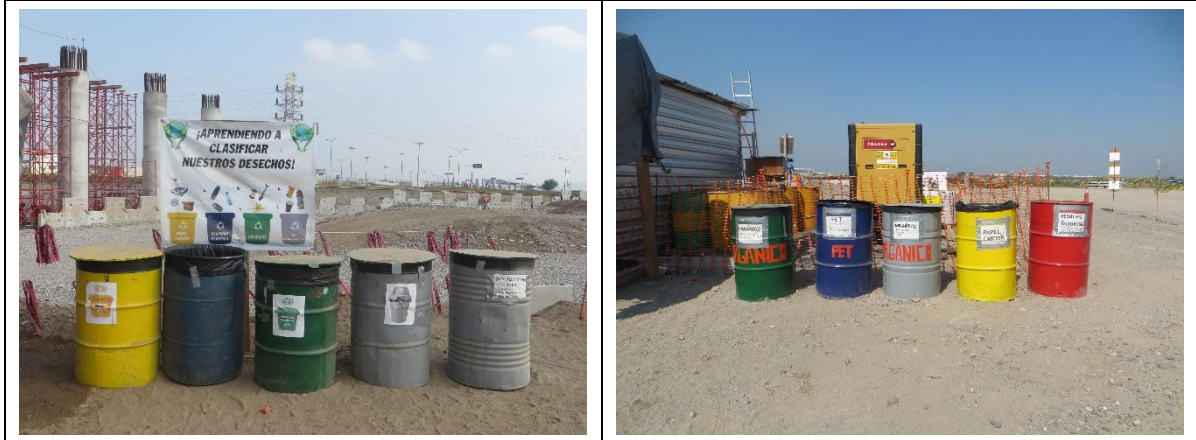
Figura II-12. Ejemplos del tipo y acondicionamiento de contenedores para residuos sólidos urbanos que se pueden usar en los frentes de trabajo para la disposición separada de los residuos.
