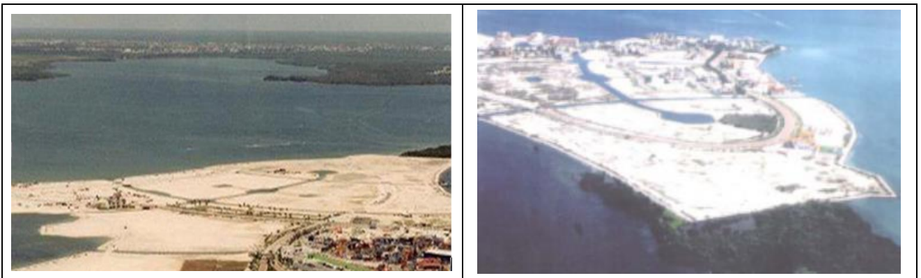
Figura II-1. Imágenes que muestran el origen artificial del predio donde se ubica el Lote 18-04-13-03 UP3, Condominio Isla Dorada, en la zona hotelera de la ciudad de Cancún.
