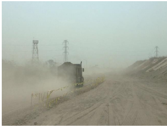
Suspensión de partículas de polvo en un camino de terracería por donde se transporta material de construcción.
