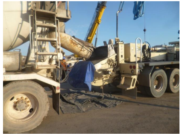
Protección de suelo contra derrames de concreto al momento de colados.
