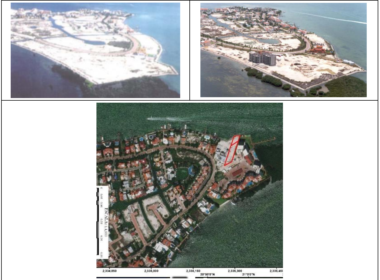
Figura 2. Imágenes que muestran el avance de las obras ejecutadas al interior del Lote 18-04-13-03 UP3, Condominio Isla Dorada, en la zona hotelera de la ciudad de Cancún.
