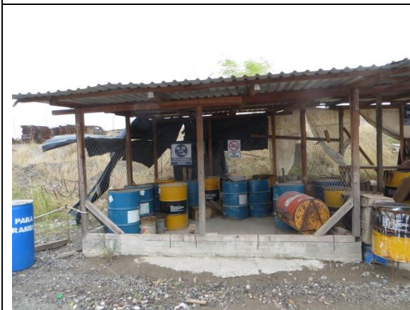
Habilitado de un almacén para la concentración momentánea de residuos peligrosos y sustancias químicas en un frente de trabajo.
