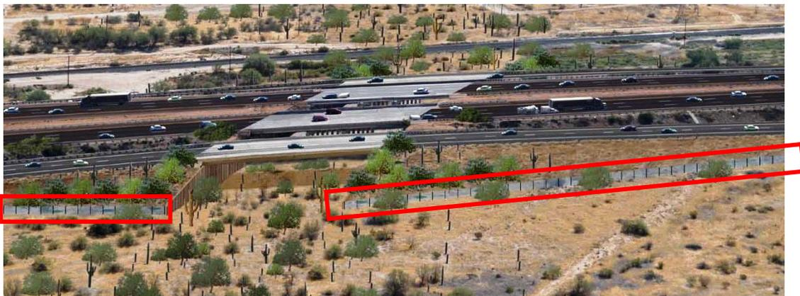
**Figura 16 Maqueta de paso superior de fauna silvestre, en una zona desértica, que muestra la disposición de la malla para detener y conducir a los animales hacia el paso**
