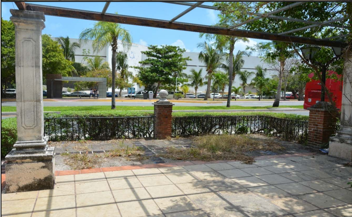
Figuras No.23 y 24 Áreas de las instalaciones del Hotel Las Velas que se encuentran abandonas, aledañas al Blvd. KukulKán.
