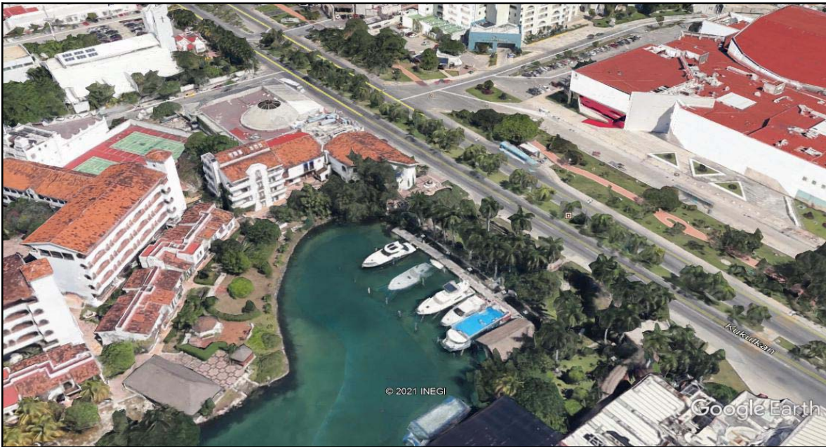
Figura No. 1 fotografía satelital de Google Earth donde se aprecia una fracción del sitio del proyecto, aledaño al Blvd. Kukulcán.
