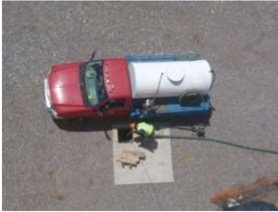
Mantenimiento de fosa séptica temporal por personal de una empresa especializada.
