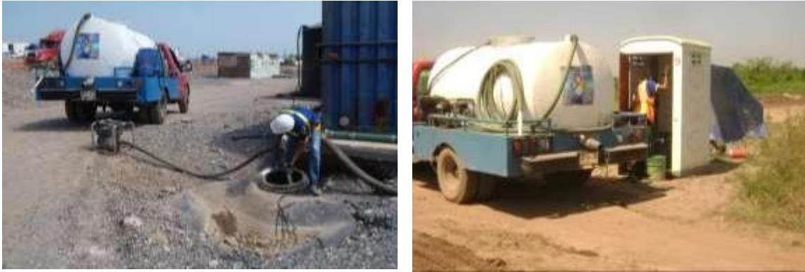
Figura 23 Ejemplo de la instalación y mantenimiento de la fosa de un sanitario temporal en sitio de construcción y de un baño portátil instalado en un frente de trabajo para uso de los trabajadores
