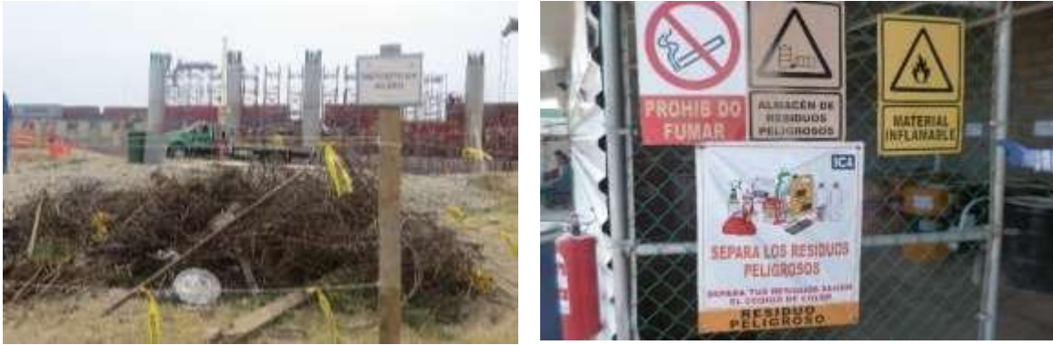
Figura 24 Ejmplo de la separación de los diferentes tipos de residuos a generarse durante las etapas de preparación del sitio y construcción del proyecto, arriba: residuos sólidos urbanos y residuos de manejo especial (madera); abajo: residuos de manejo especial (
