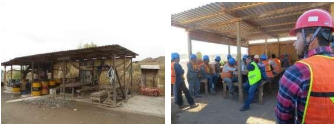
Figura 25 Ejemplo de la habilitación de áreas para el consumo de alimentos y descanso para los trabajadores de obra durante la etapa de construcción
