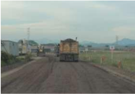
Transporte de material sin protección para evitar la resuspensión de partículas
