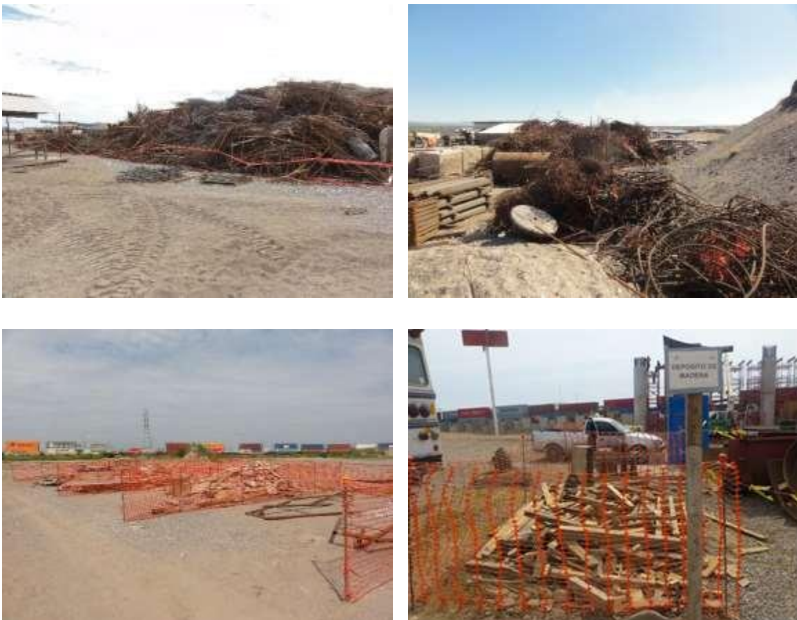
Figura 38 Ejemplo de la habilitación y señalización de áreas para la disposición temporal de residuos de manejo especial durante la etapa de construcción.
