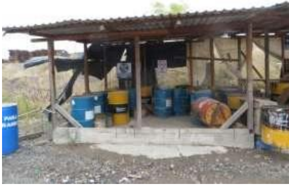
Habilitado de un almacén para la concentración momentánea de residuos peligrosos y sustancias químicas en un frente de trabajo.
