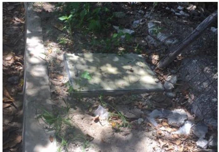
Fotografía de registro de aguas negras del predio para lotes 03 y 02, en ese orden, previo a la red municipal, sobre el area de banqueta.
