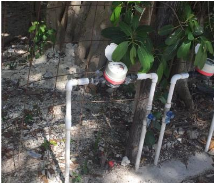
Fotografía de medidor de aguas potable del predio para los lote 02 y 01, en ese orden, previo al ingreso a cada casa por construir.
