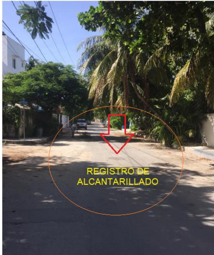
Fotografía de registro de drenaje
