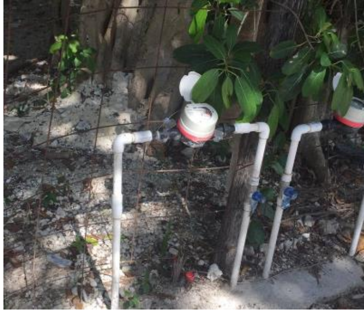
Fotografía de medidor de aguas potable del predio para los lote 02 y 01, en ese orden, previo al ingreso a cada casa por construir.
