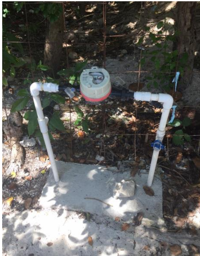
Fotografía de medidor de aguas potable del predio para lote 03, previo al ingreso a la casa por construir.
