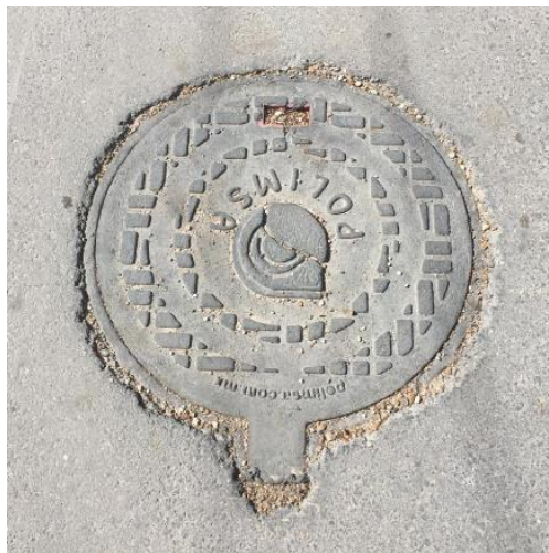
Fotografía de registro de drenaje
