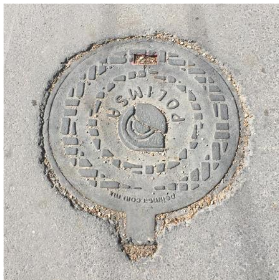
Fotografía de registro de drenaje
