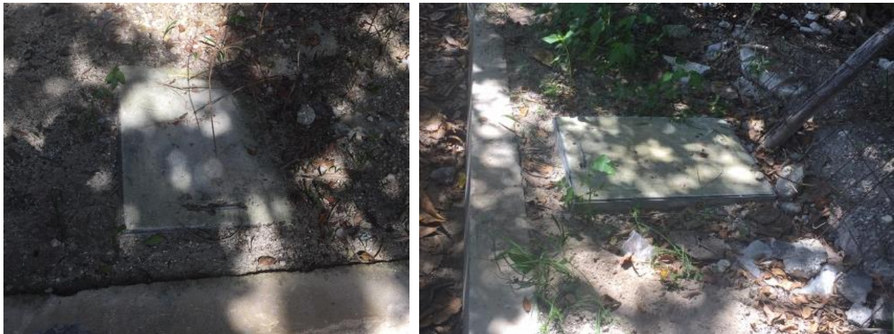
Fotografía de registro de aguas negras del predio para lotes 03 y 02, en ese orden, previo a la red municipal, sobre el area de banquetta.
