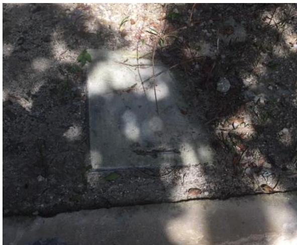
Fotografía de registro de aguas negras del predio para lotes 03 y 02, en ese orden, previo a la red municipal, sobre el area de banqueta.
