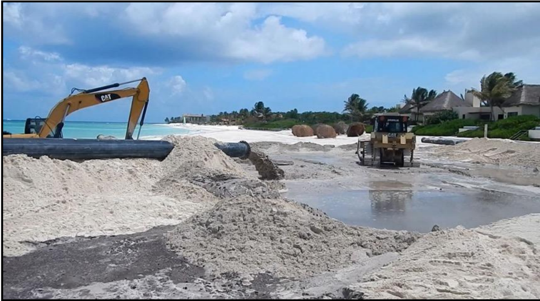
FIGURA 2.18 EJEMPLOS DE VERTIMIENTO Y ACOMODO DE ARENA CON MAQUINARIA
