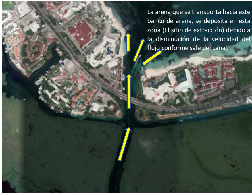
FIGURA 4.40 ACUMULACIÓN DE SEDIMENTO POR EL CANAL DE SIGFRIDO AL BANCO DE ARENA 2.
