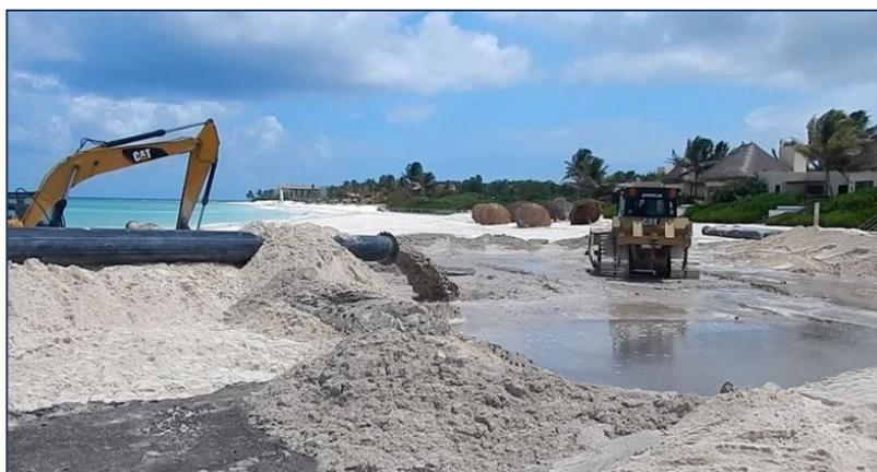
FIGURA 2.22 EJEMPLOS DE ACOMODO DE ARENA CON MAQUINARIA
