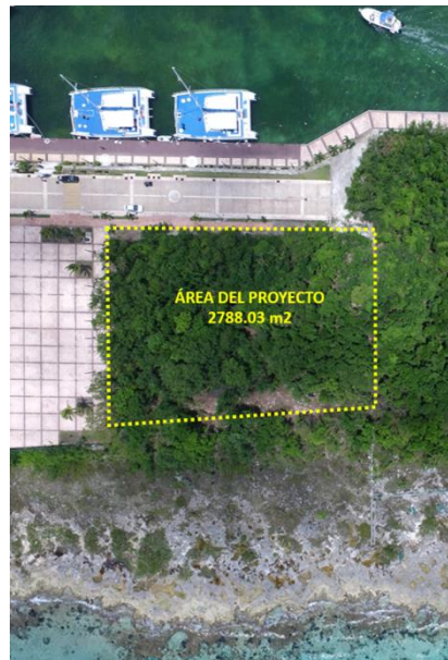
Delimitación del área del proyecto con una superficie de 2,788.03 m 2 . Foto aérea con dron de fecha junio del 2021.
