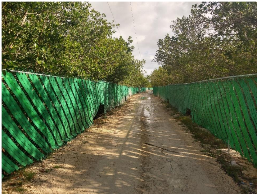
Figura 45. Vista del camino comunal de terracería a pie del mismo, el cual forma parte de una vía de comunicación.
