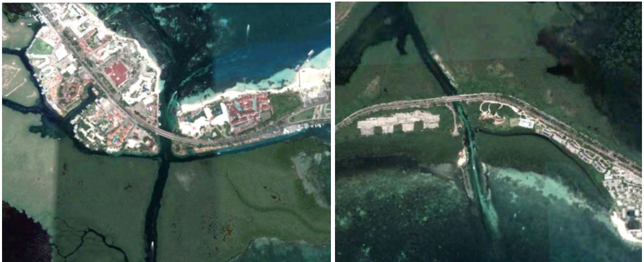
Figura 11. Bocas de comunicación (Norte-imagen izquierda; Sur-imagen derecha).
