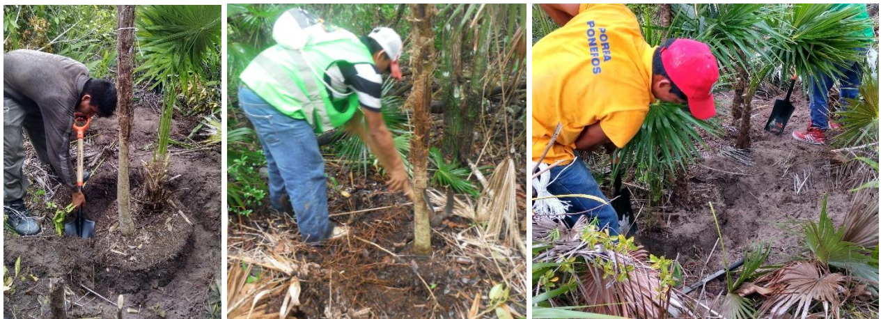
Construcción de la zanja de banqueo
