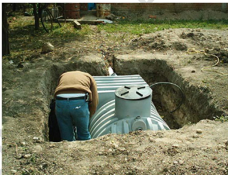
Figura 5.-Imagen ejemplo de la instalación de la SEPTI BOSS
